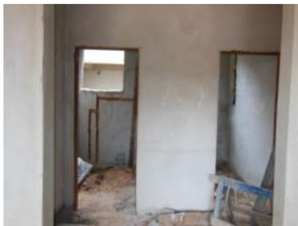
PC-7.3.6 - Cômodos ainda sem o revestimento cerâmico
