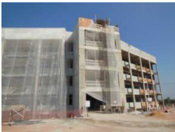
PC-7.1.3 - Fachada frontal (transição)
