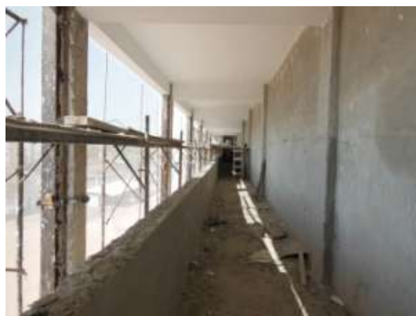
PC-7.1.16 - Laje revestida e emassada
