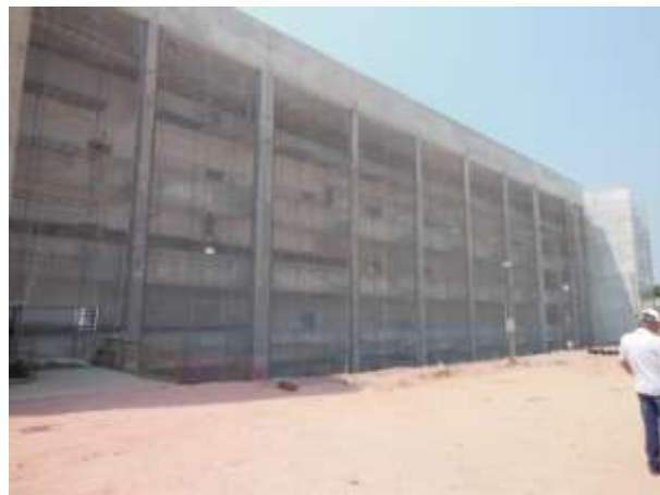
PC-7.1.2 - Fachada frontal (centro)
