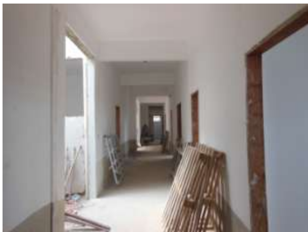
PC-7.2.5 - Interior com emassamento
