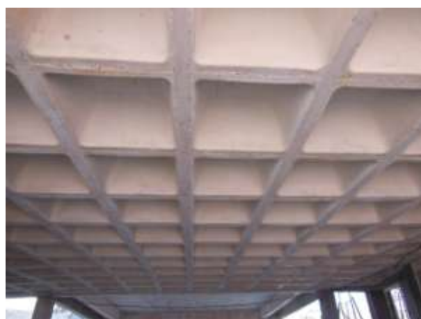
PC-7.1.18 - Laje nervurada (transição)
