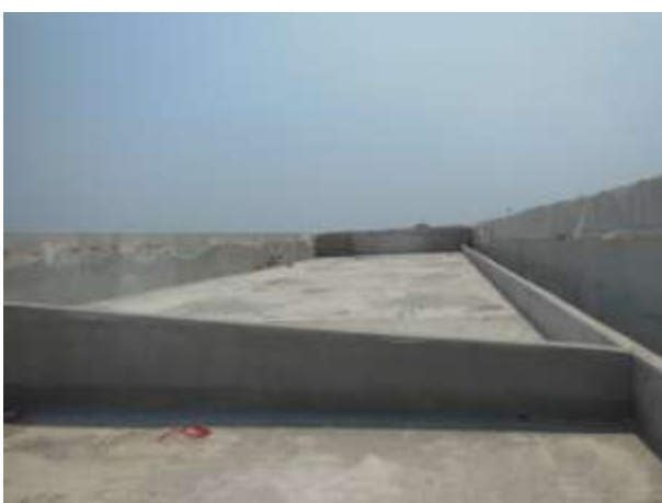
PC-7.1.17 - Laje de cobertura (5º andar)
