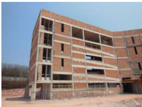
PC-7.1.4 - Fachada posterior (transição)
