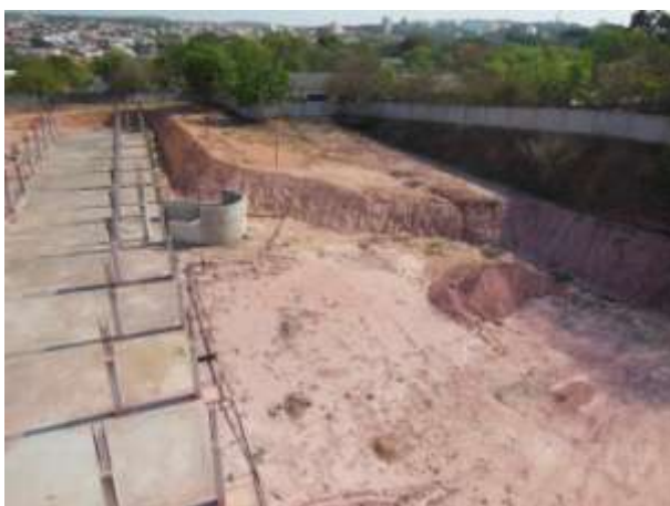
PC-7.1.11 - Escavação do auditório
