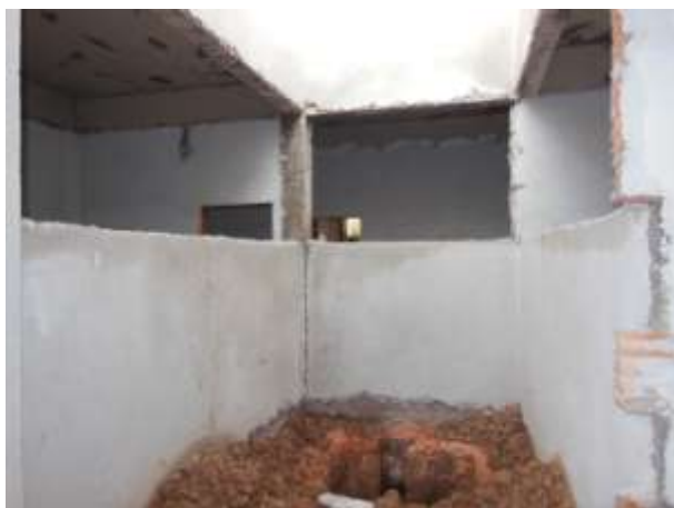
PC-7.3.7 – Escavação para drenagem pluvial
