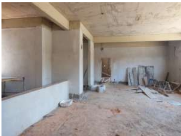
PC-7.3.5 - Interior com alvenaria rebocada
