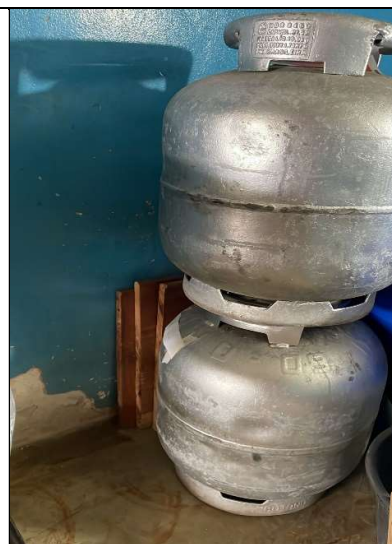
Figura 23 - Detalhe do armazenamento de dois botijões de gás
