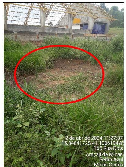
Figura 18 - Detalhe do local da fossa
