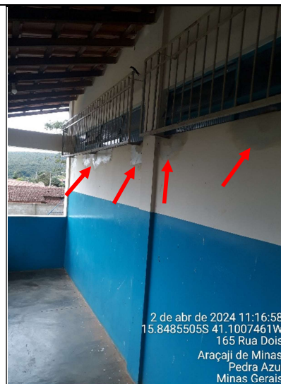
Figura 20 - Detalhe dos locais que necessitam de pintura
