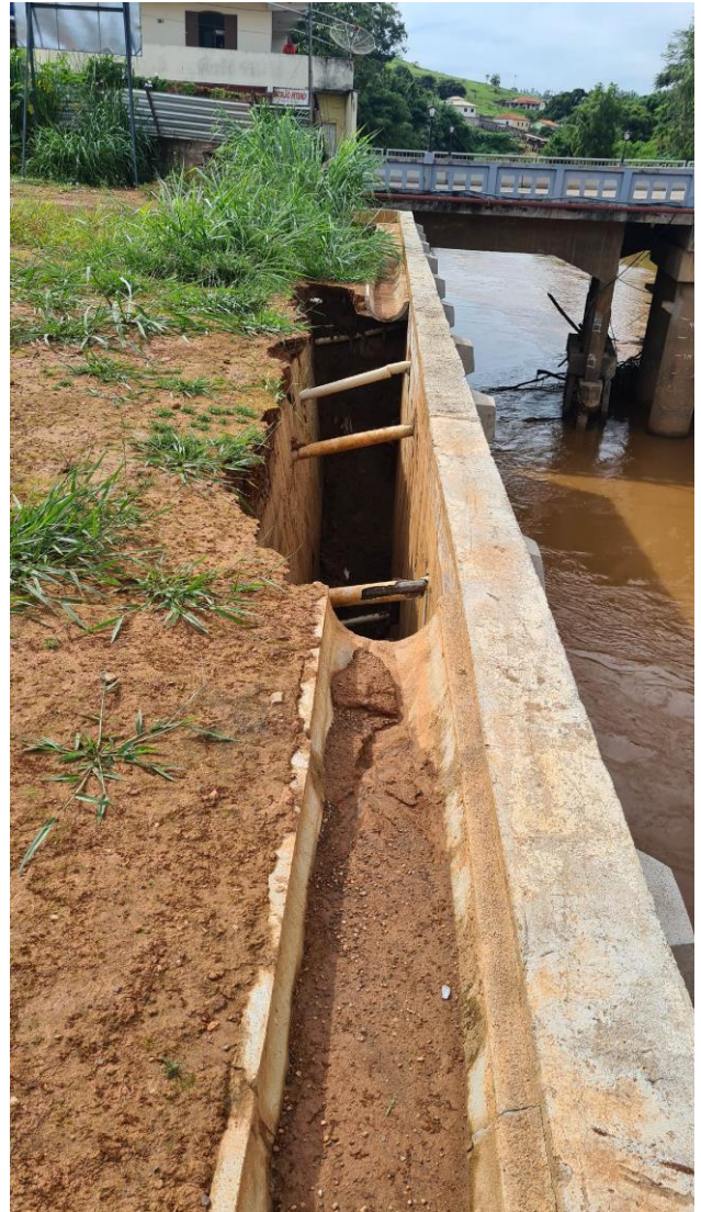
Foto 2- Erosão no trecho inicial da contenção, no trecho da contenção existente
