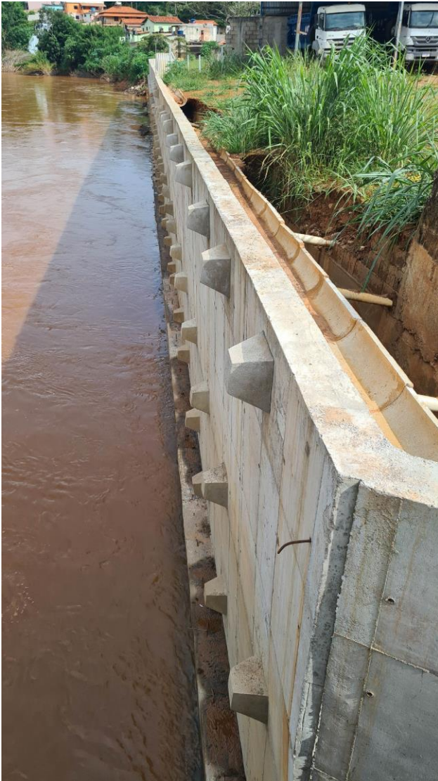
Foto 1 – Vista frontal no início da Contenção
