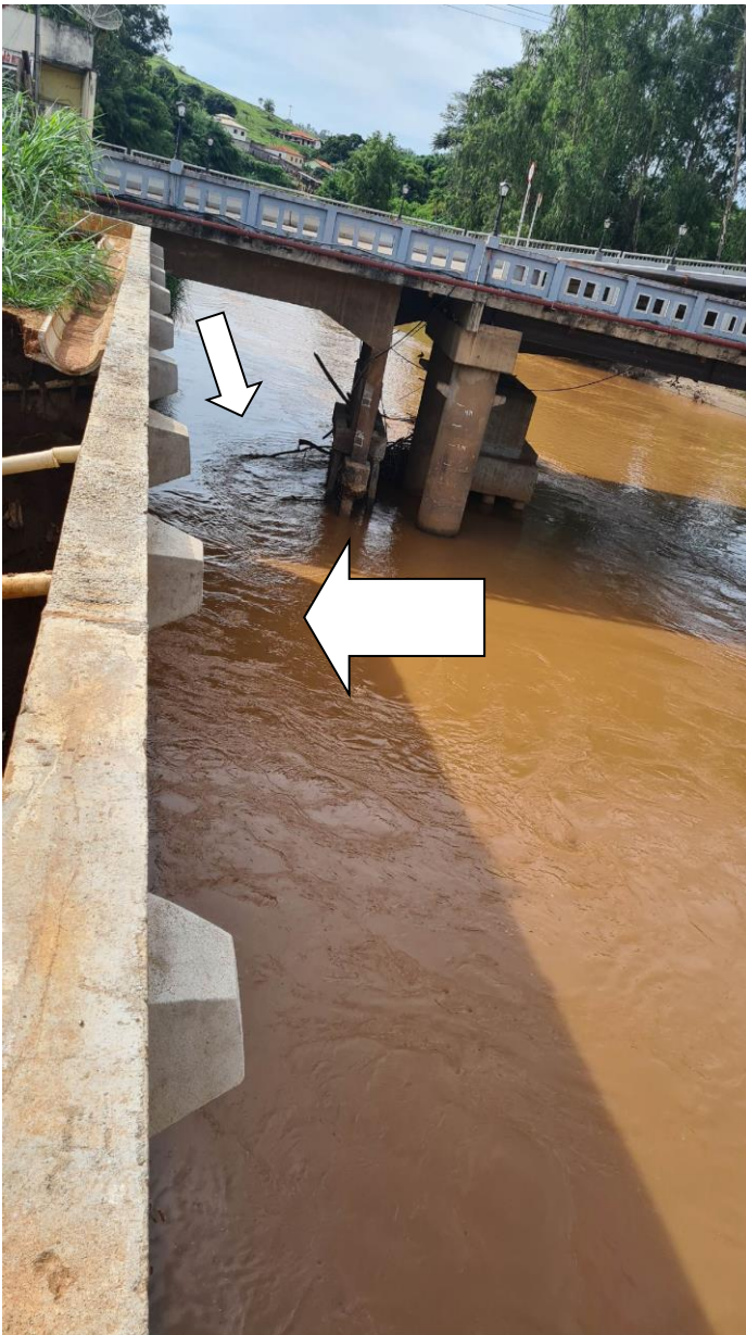
Foto 3 – Vórtex formado a partir da limpeza do apoio e do desassoreamento do vão inicial sob as OAES
