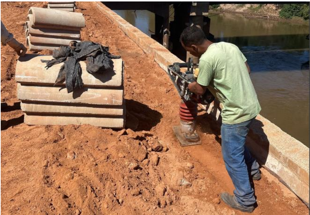
Foto 6 - Compactação manual da camada superficial do terrapleno
