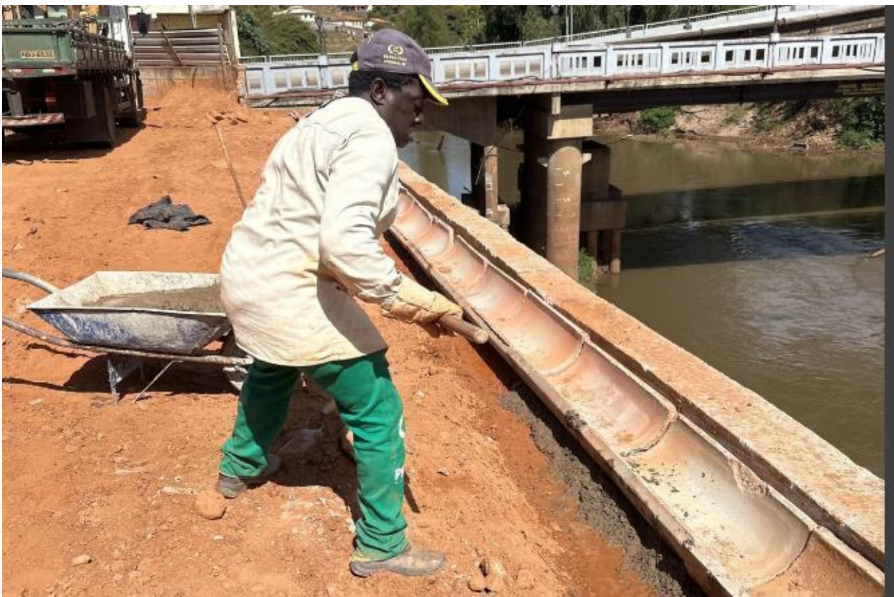
Foto 7 - Colocação de canaleta meia cana, para captação de condução da drenagem superficial
