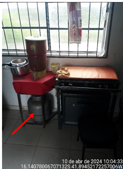
Figura 19 - Detalhe de botijão de GLP no forno
