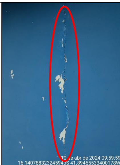
Figura 4 - Detalhe de trinca na parede, lado externo
