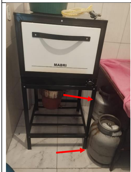
Figura 39 - Detalhe de dois botijões de gás no forno
