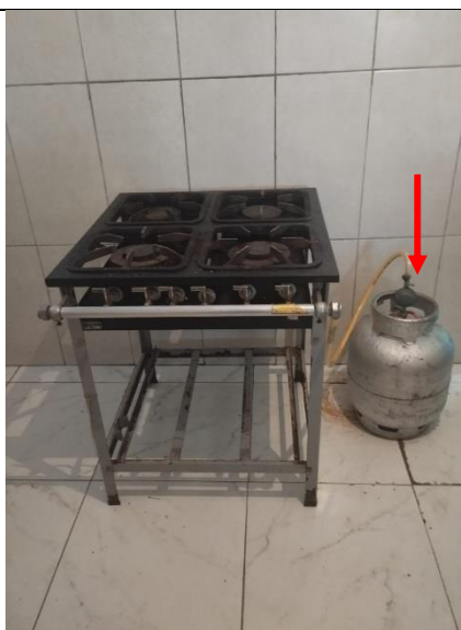
Figura 40 - Detalhe do botijão de gás no fogão
