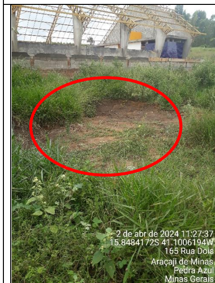
Figura 18 - Detalhe do local da fossa
