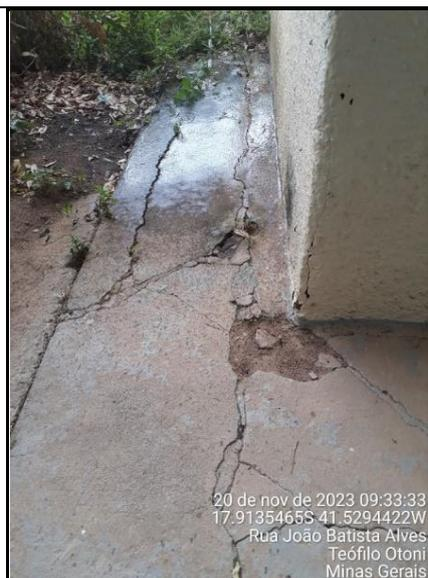
**Figura 3 - Detalhe da calçada com rachaduras**
