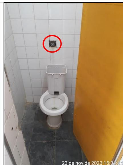
**Figura 212 - Detalhe da falta de acabamento da válvula de descarga em box do banheiro feminino**
