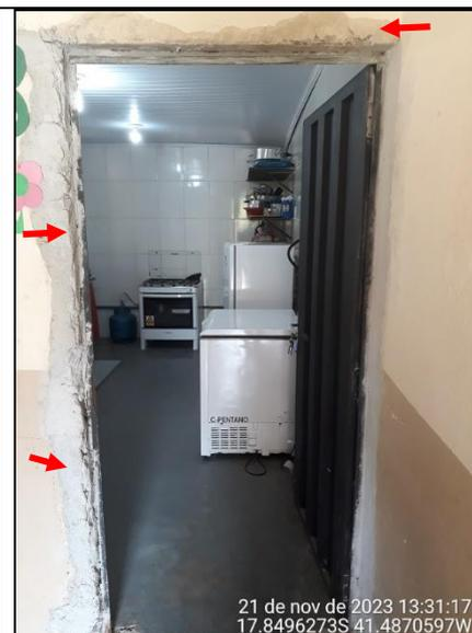
**Figura 83 - Detalhes de problemas de falta de acabamento da argamassa de assentamento do batente da cozinha**
