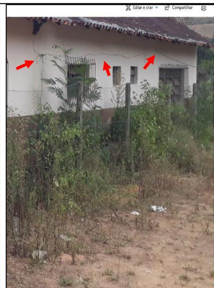
Figura 26 - Detalhe de cabo elétrico aparente e em baixa altura
