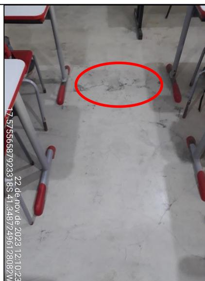
**Figura 145 - Detalhe de desgaste no piso**
