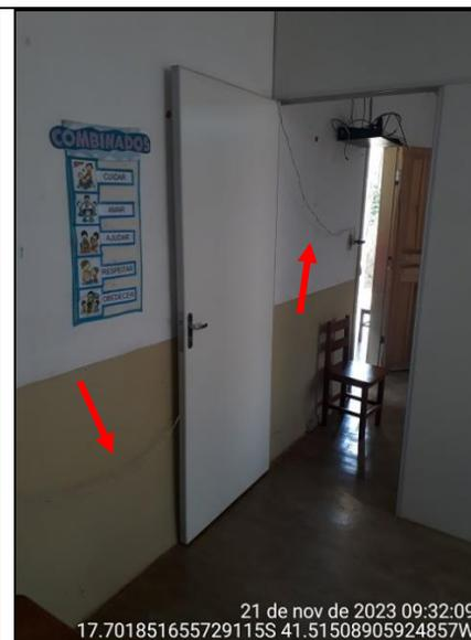
**Figura 59 - Detalhe de cabos elétricos aparentes**
