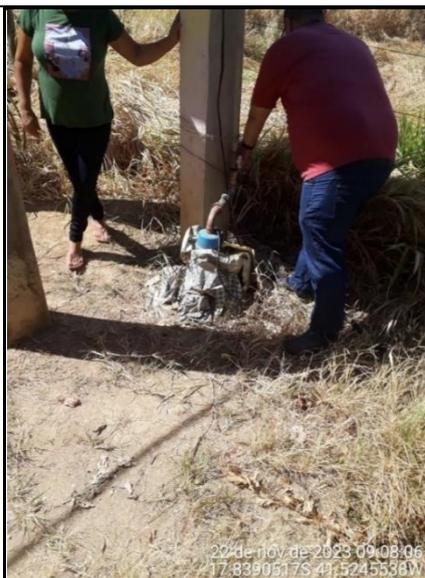
**Figura 114 - Detalhe de poço sem proteção e sem outorga do IGAM**
