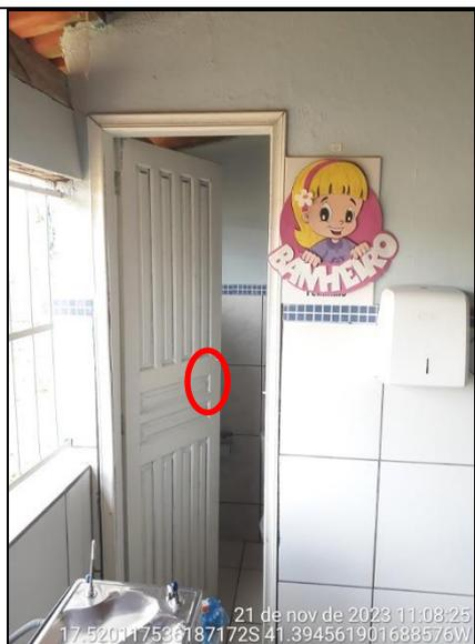
**Figura 69 - Detalhe de ausência de maçaneta e fechadura na porta do banheiro feminino**
