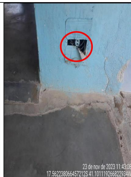
**Figura 185 - Detalhe de cabo elétrico aparente**
