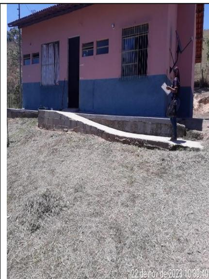
**Figura 123 - Detalhe da rampa maior sem guarda corpo e corrimão**
