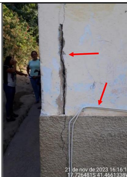
**Figura 103 - Detalhe de rachadura na parede frontal e cabos elétricos aparentes**
