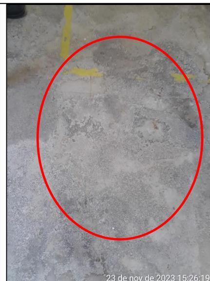
**Figura 215 - Detalhe de desgaste no piso da sala de aula**
