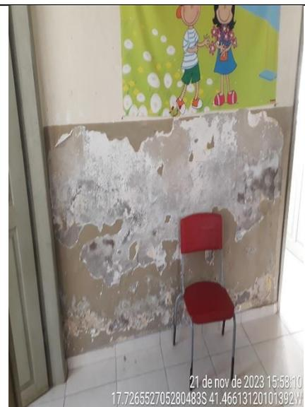
**Figura 108 - Detalhe de pintura desgastada da parede**
