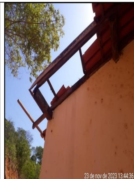
**Figura 194 - Detalhe de problema no madeiramento e telha do beiral da cobertura**
