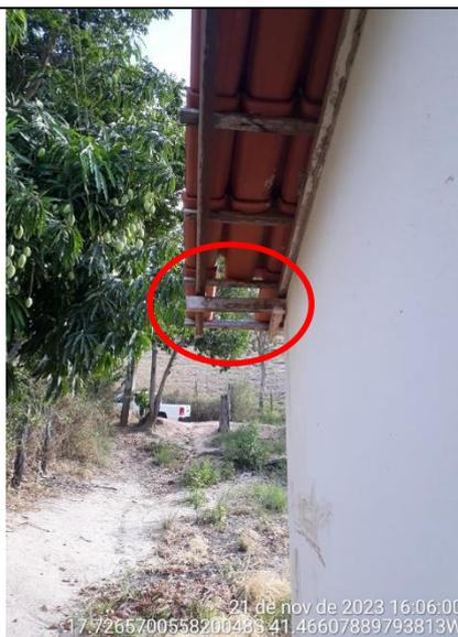
**Figura 100 - Detalhe de problema na madeiramento e telhas do beiral**
