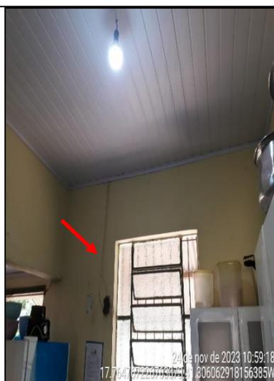
**Figura 241 - Detalhes de cabos elétricos aparentes sem proteção**
