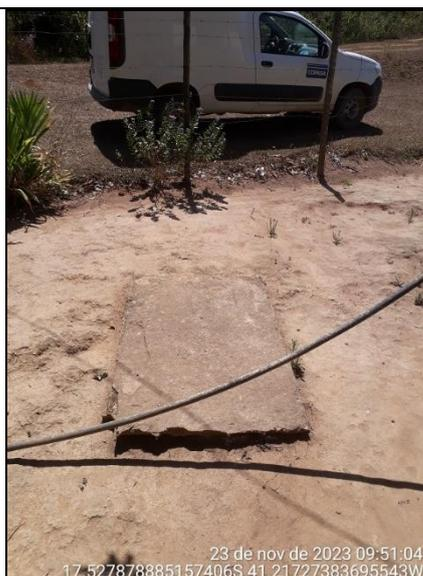
**Figura 178 - Detalhe de tampa de fossa sem proteção**
