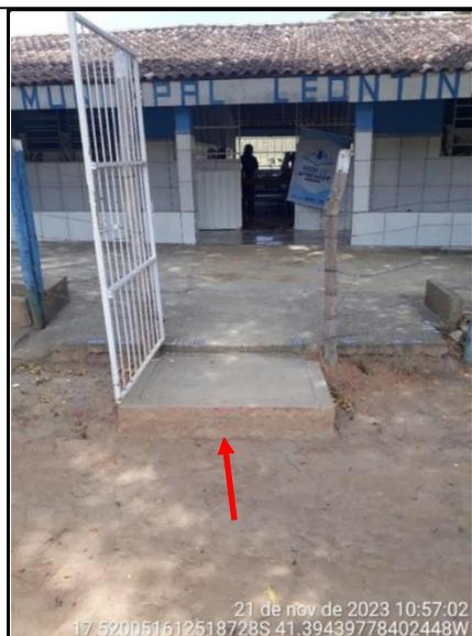
**Figura 63 - Detalhe de ausência de rampa de acesso à escola**
