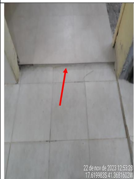
**Figura 146 - Detalhe do desnível existente entre o piso do corredor (circulação) e o nível do piso do banheiro**
