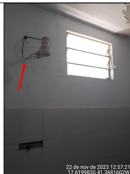
**Figura 144 - Cabo elétrico aparente com remendo**
