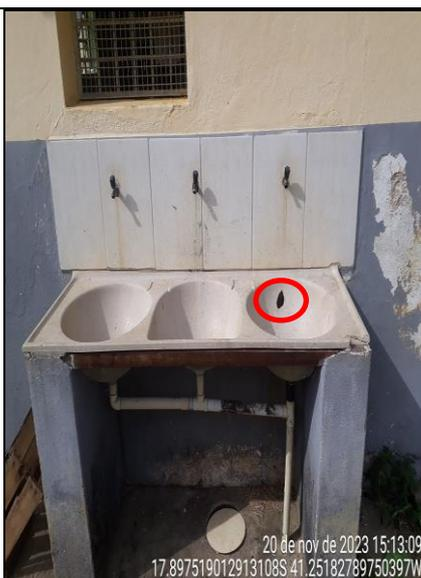
Figura 49 - Detalhe de instalação sanitária precária e tanque furado
