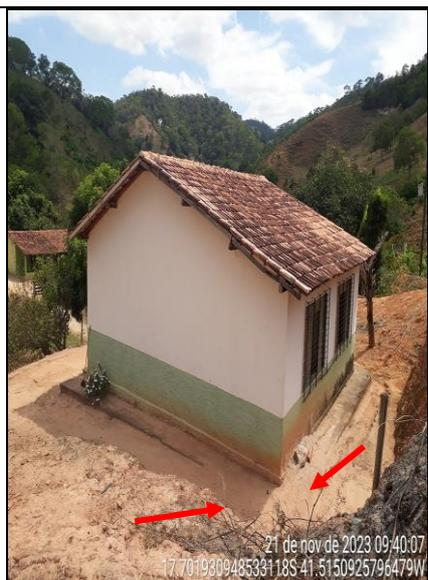
**Figura 57 - Detalhe de terra sobre a calçada lateral**
