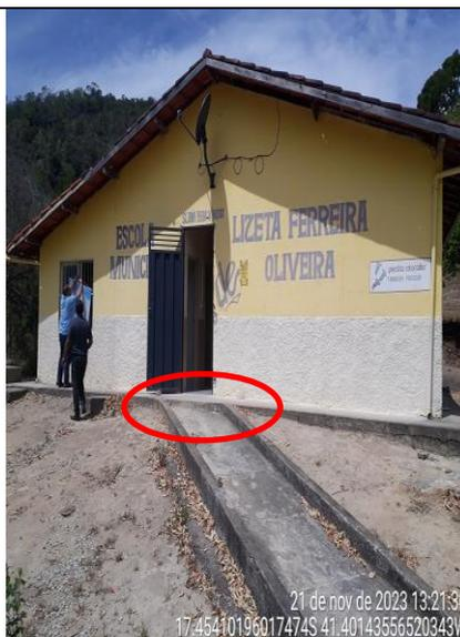
**Figura 76 - Detalhe de falta de nivelamento entre a rampa e calçada frontal**
