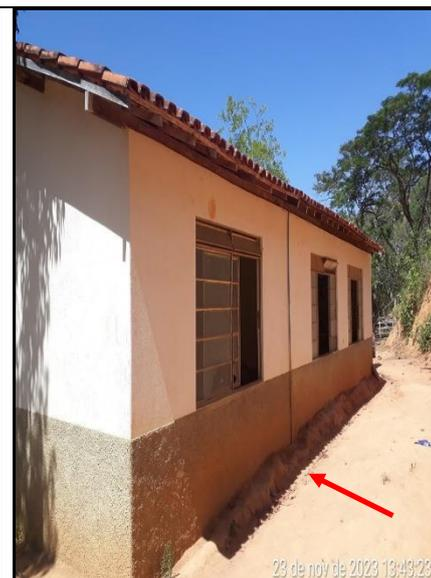
**Figura 200 - Detalhe de ausência de calçada externa**
