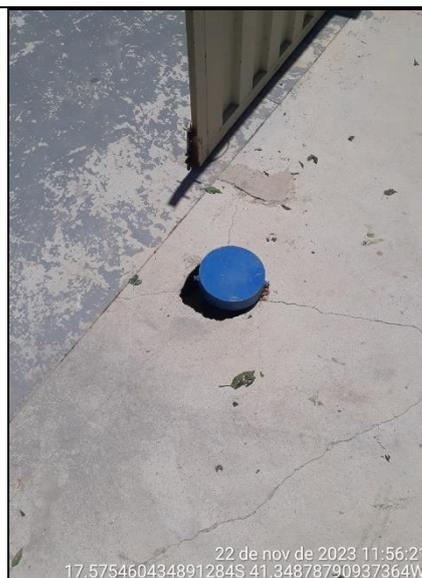
**Figura 142 - Detalhe de poço recém perfurado e sem outorga do IGAM**
