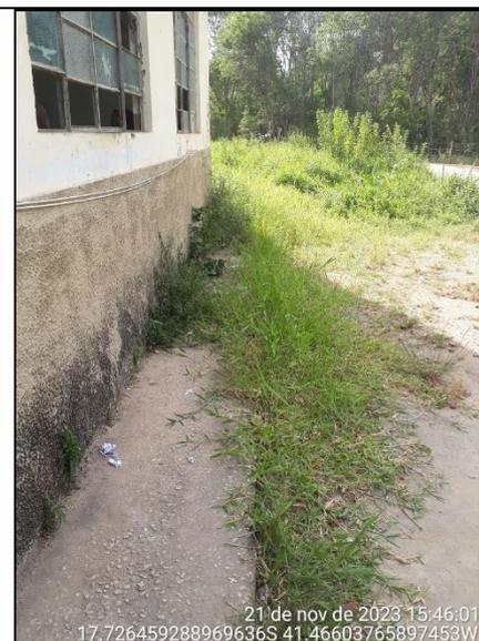
**Figura 107 - Detalhe de vegetação sobre calçada frontal**
