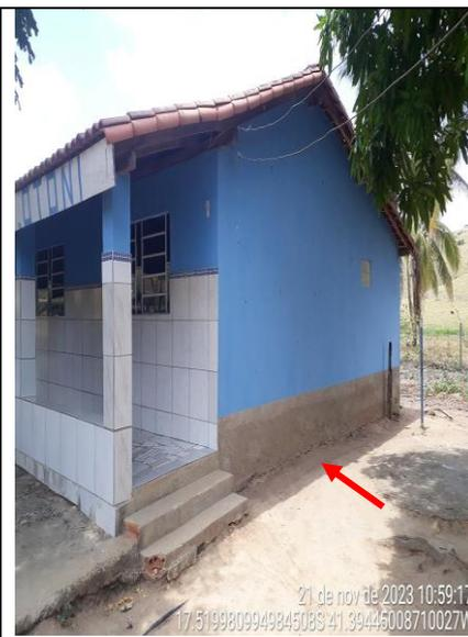
**Figura 71 - Detalhe da ausência de calçada na lateral da escola**
