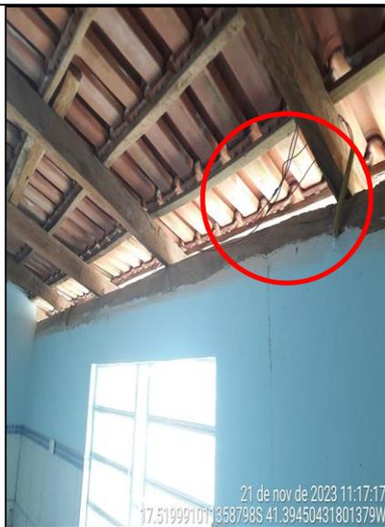
**Figura 73 - Detalhe de cabos elétricos aparentes e com remendos**
