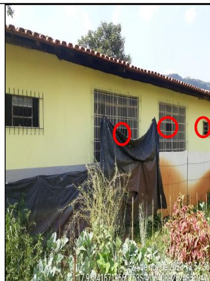
**Figura 251 - Detalhe da lona colocada para cobrir as janelas com vidros quebrados**
