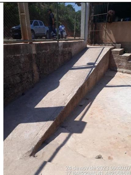
Figura 216 - Detalhe de rampa sem guarda corpo e corrimão
