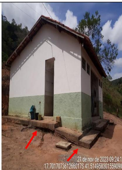
**Figura 52 - Detalhe de falta de acessibilidade na calçada lateral**
