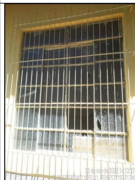
**Figura 152 - Detalhe de janela com vidro quebrado**
