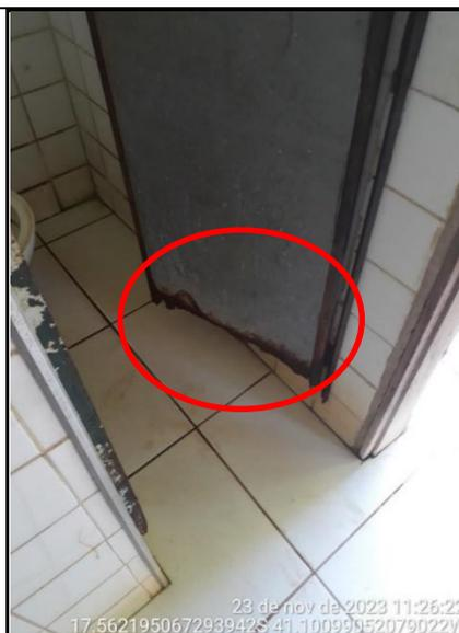
**Figura 181 - Detalhe de oxidação na porta do box do banheiro**
