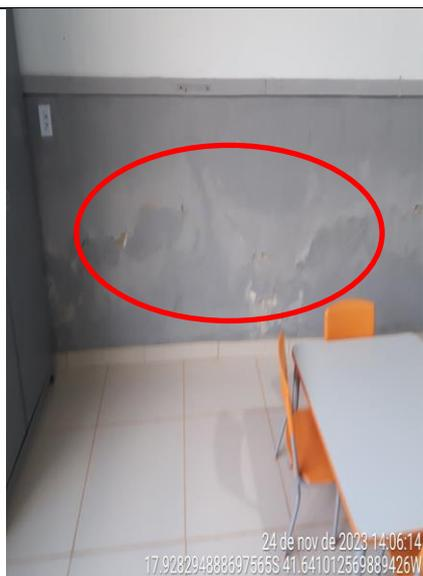
**Figura 246 - Detalhe de manchas de umidade na parede da sala de aula**
