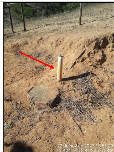
**Figura 164 - Detalhe de poço sem proteção**
