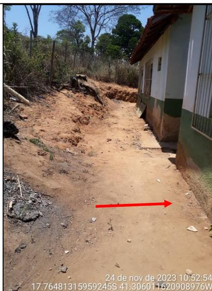
**Figura 235 - Detalhe de falta de calçada em alguns trechos dos ambientes externos**
