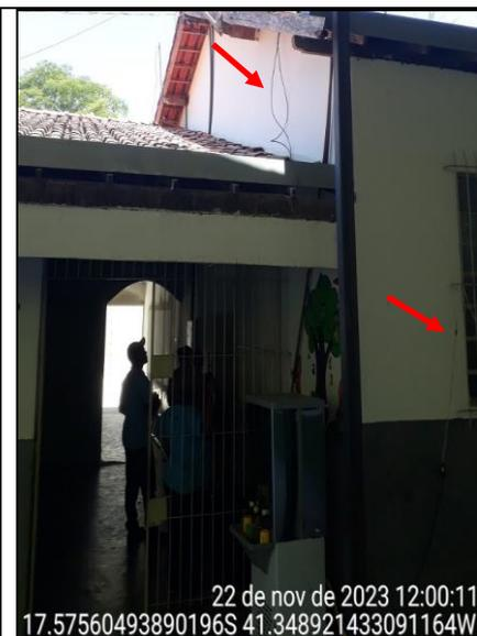
**Figura 143 - Detalhe de cabos elétricos aparentes**
