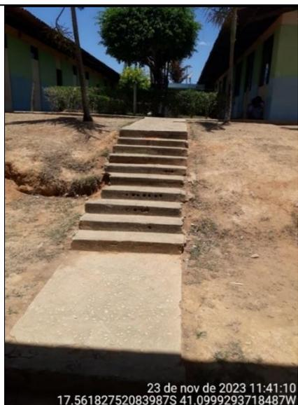
**Figura 180 - Detalhe da escada de acesso à quadra, sem guarda corpo e corrimão**
