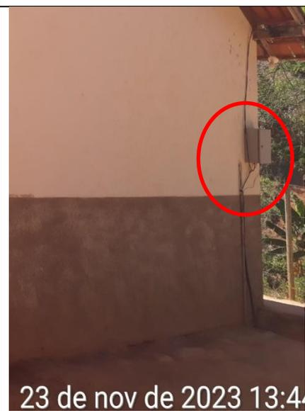
**Figura 203 - Detalhe do quadro de entrada de energia da escola, com cabos aparentes, sem proteções**
