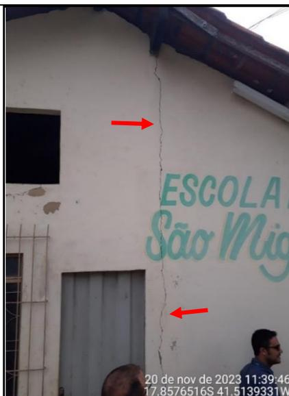
**Figura 28 - Detalhe de rachadura na parede frontal**
