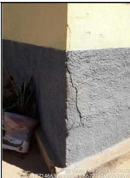
**Figura 111 - Detalhe de rachadura na parede**
