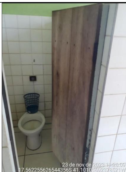
**Figura 183 - Detalhe de bacia sanitária sem assento**
