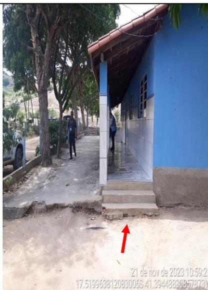
**Figura 64 - Detalhe de falta de acessibilidade na lateral da escola**
