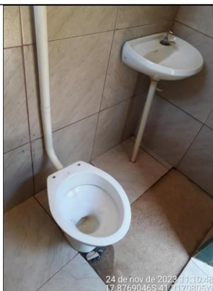
**Figura 231 - Detalhes da bacia sanitária sem assento e ausência parcial de pisos no banheiro**
