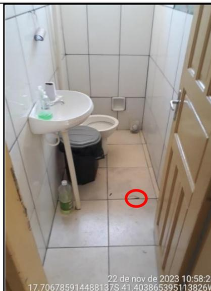
**Figura 127 - Detalhe de bacia sanitária sem assento e piso quebrado no banheiro masculino**
