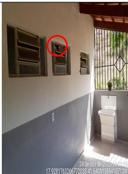
**Figura 249 - Detalhe de janela da cozinha com vidro quebrado**
