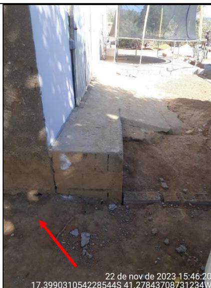
**Figura 163 - Detalhe de ausência de calçada lateral**
