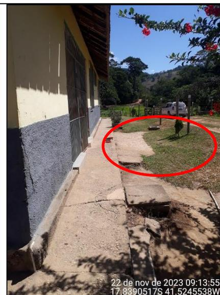
Figura 119 - Detalhe de rampa de acesso inadequada
