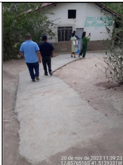
**Figura 27 - Detalhe da rampa com declividade elevada e sem guarda corpo e corrimão**
