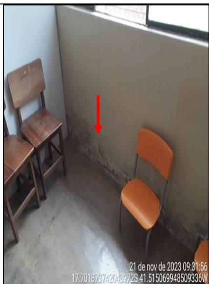
**Figura 54 - Detalhe de umidade na parede da sala de aula**
