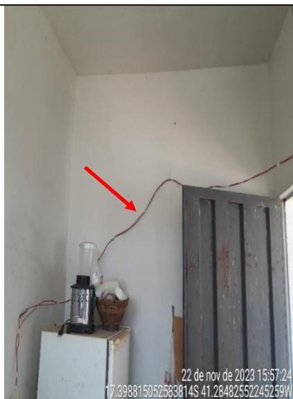
**Figura 159 - Detalhe de cabo elétrico aparente e com remendo**
