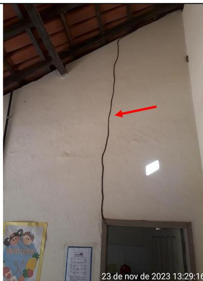
**Figura 193 - Detalhe do caminho de cupim em direção ao madeiramento**
