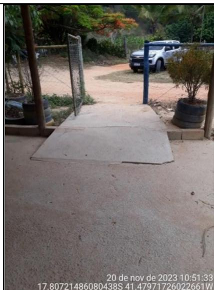
Figura 15 - Detalhe da rampa com declividade superior a 8,33%
