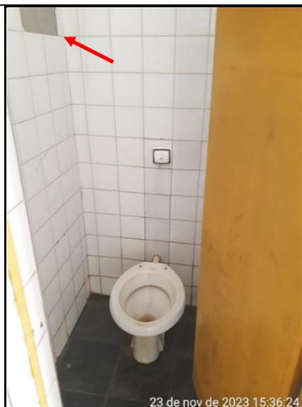
**Figura 210 - Detalhe da bacia sanitária sem assento e falta de azulejos na parede – box do banheiro masculino**
