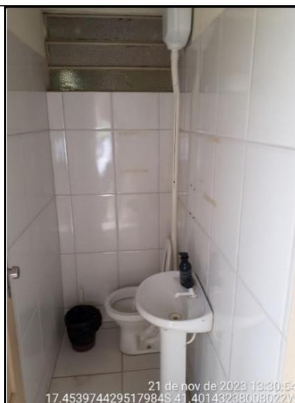
**Figura 78 - Detalhe de bacia sanitária sem assento**
