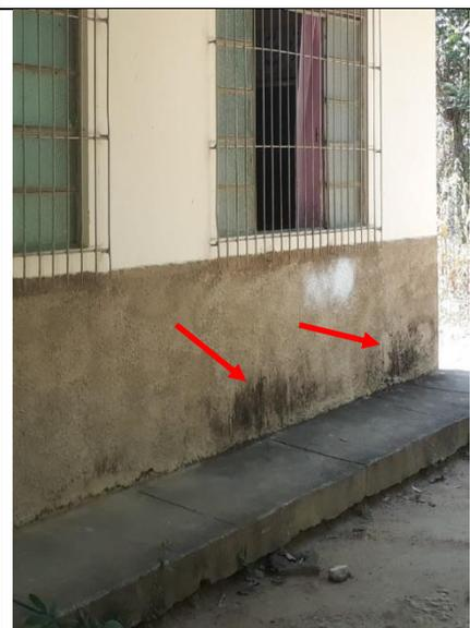
**Figura 179 - Detalhes manchas de umidade na parede**
