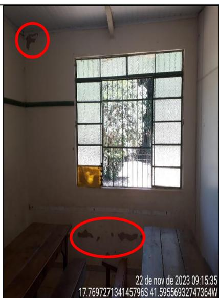
Figura 120 - Detalhe de descascamento da pintura
