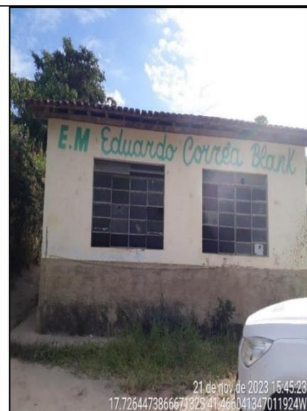
**Figura 104 - Detalhe das janelas da fachada com vidros quebrados**
