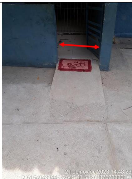
**Figura 87 - Detalhe da largura insuficiente da rampa e platibanda para passagem da cadeira de rodas**
