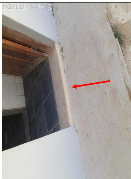
Figura 204 - Detalhe do desnível entre calçada e banheiro
