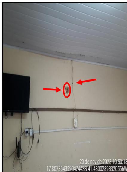
Figura 19 - Detalhe de buraco na parede e fiação elétrica aparente, com remendo
