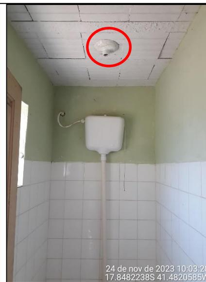
Figura 227 - Detalhe da ausência de lâmpada no banheiro feminino
