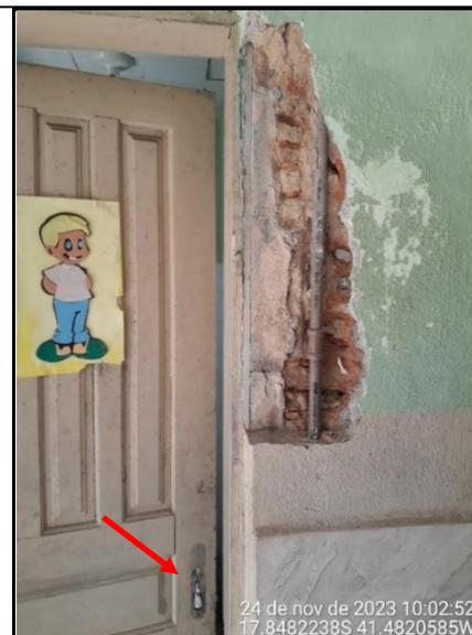
Figura 219 - Detalhes de buraco na parede e porta do banheiro masculino sem maçaneta
