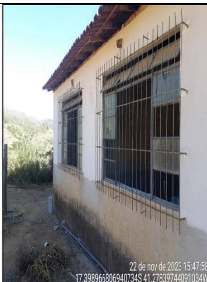
**Figura 160 - Detalhes de janela com vidros quebrados e vãos sem vidros**
