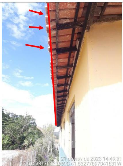
**Figura 96 - Detalhe da falta de alinhamento das telhas do beiral**
