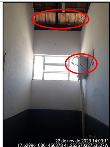
Figura 155 - Detalhe de instalação elétrica aparente e com remendos
