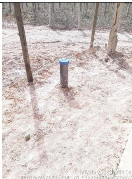
**Figura 90 - Detalhe do poço recém perfurado, sem outorga do IGAM**
