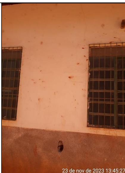
**Figura 202 - Detalhe de buraco na parede e problema na pintura**
