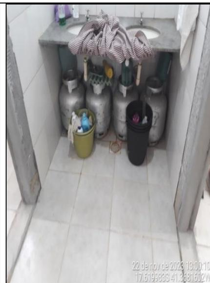
**Figura 140 - Detalhe de armazenamento irregular de gás GLP**
