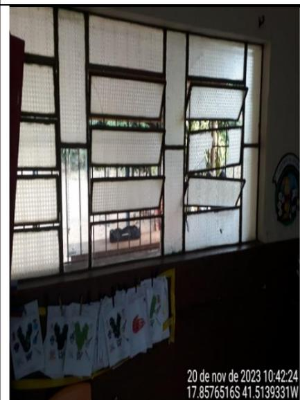
Figura 20 - Detalhe de janela com vidros quebrados
