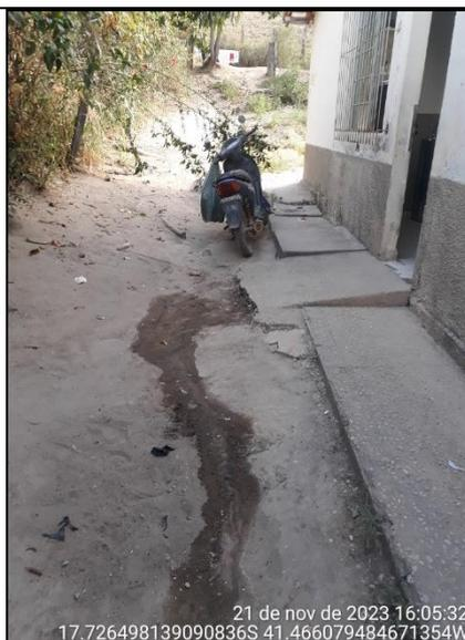
**Figura 106 - Detalhe de rampa de acesso inadequada quanto a concordância com a calçada**
