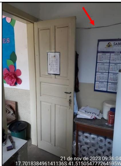
**Figura 58 - Detalhe de cabo elétrico aparente**
