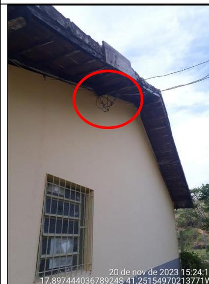
Figura 50 - Detalhe de cabos elétricos aparentes e com remendos
