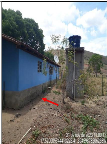
**Figura 72 - Detalhe da ausência de calçada na parte posterior da escola**
