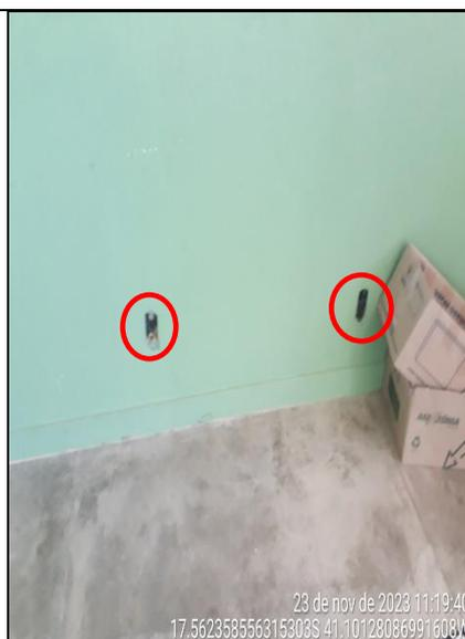
**Figura 190 - Detalhes das caixas das tomadas sem espelhos**
