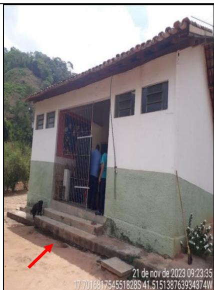
**Figura 51 - Detalhe de falta de rampa de acesso à escola**
