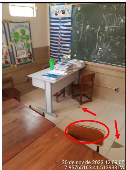
**Figura 36 - Detalhe de pisos quebrados e mobiliário desgastado**
