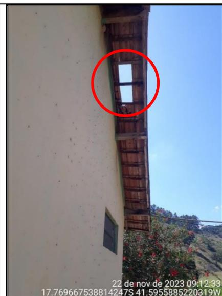
**Figura 113 - Detalhes de problemas no madeiramento e telhas do beiral**
