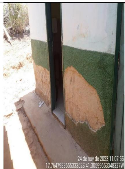
**Figura 234 - Detalhe de problema de desprendimento de revestimento da parede**
