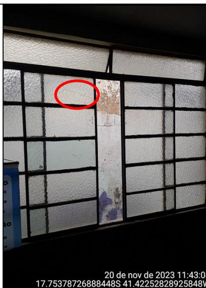
**Figura 37 - Detalhe de janela com vidro quebrado**
