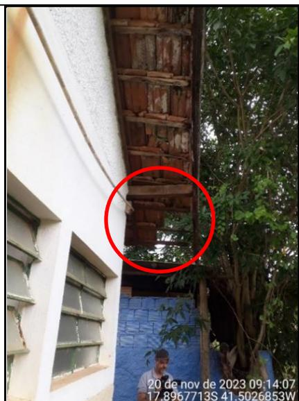
Figura 9 - Detalhes de problemas nas telhas e madeiramento do beiral da cobertura
