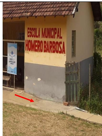
**Figura 39 - Detalhe de trecho irregular na rampa de acesso**
