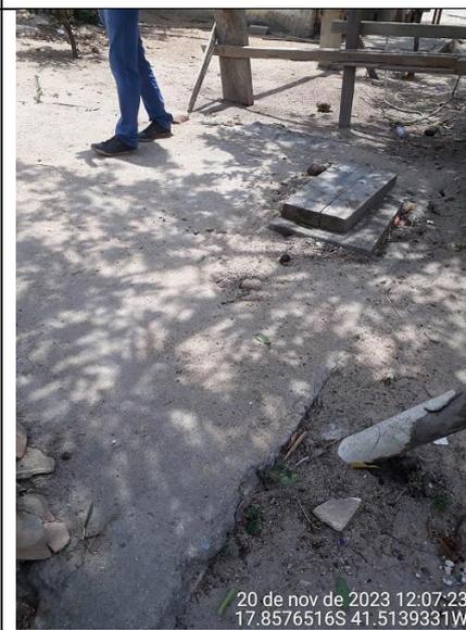
**Figura 38 - Detalhe de tampa de fossa sem proteção**
