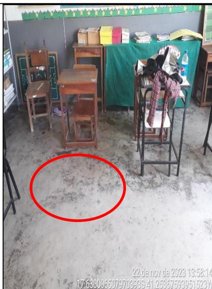
Figura 154 - Detalhe de manchas de desgaste no piso da sala de aula
