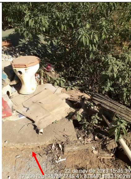
**Figura 162 - Detalhe da tampa da fossa sem proteção**
