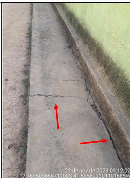
**Figura 112 - Detalhe de rachaduras na calçada**
