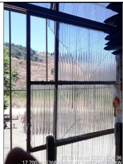
**Figura 125 - Detalhe de janela com vidros quebrados**
