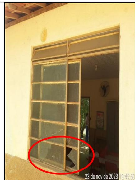
**Figura 197 - Detalhe de janela com vidro quebrado**
