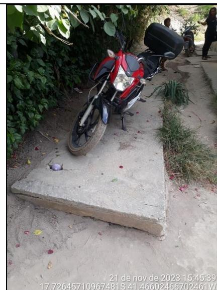
**Figura 105 - Detalhe da tampa da fossa sem proteção**
