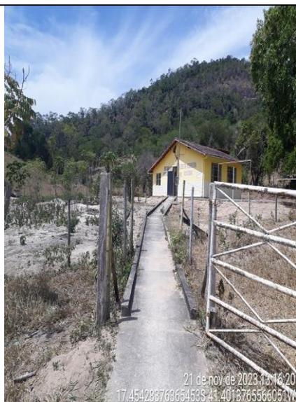
**Figura 75 - Detalhe de rampa de acesso sem corrimão**
