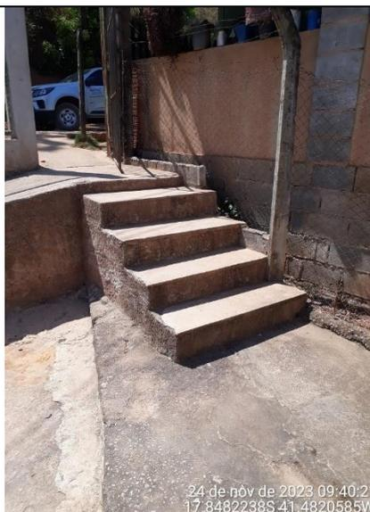
Figura 217 - Detalhe de escada sem guarda corpo e corrimão
