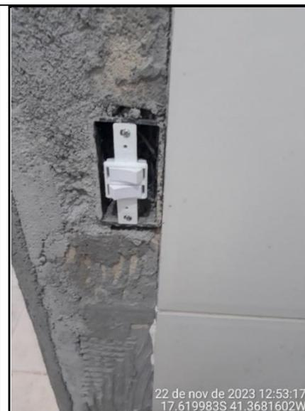
**Figura 137 - Detalhe de interruptor aparente, sem espelho**
