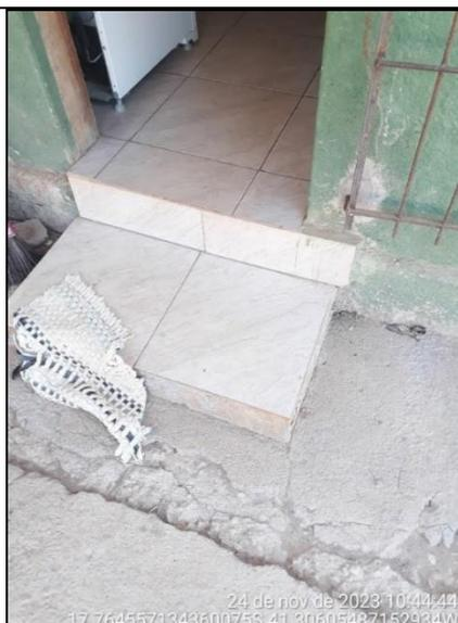
**Figura 229 - Detalhe do desnível entre a área externa e a cozinha**
