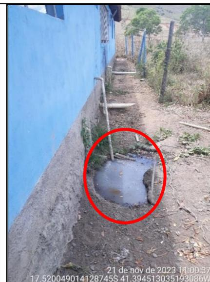
**Figura 65 - Detalhe de transbordamento de efluente de esgoto por falta de caixa de gordura**
