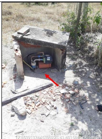
**Figura 81 - Detalhe do poço sem proteção e sem outorga do IGAM e bomba com cabos elétricos aparentes**
