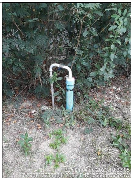
Figura 21 - Detalhe do poço sem proteção e sem outorga do IGAM
