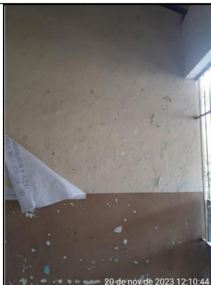
**Figura 33 - Detalhe da pintura precária**
