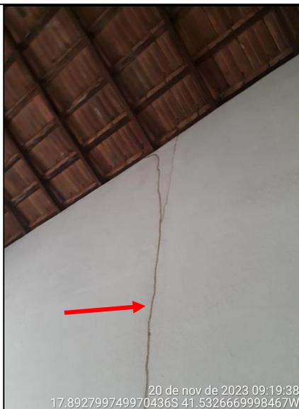
Figura 13 - Detalhe do caminho de cupim na parede em direção ao madeiramento da cobertura
