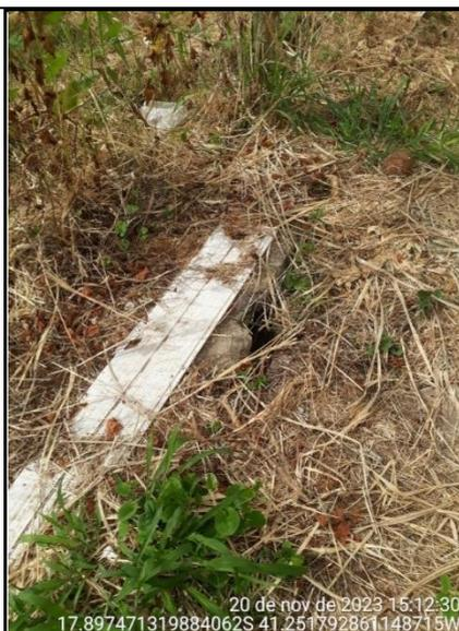
Figura 46 - Detalhe da tampa da fossa quebrada e sem proteção
