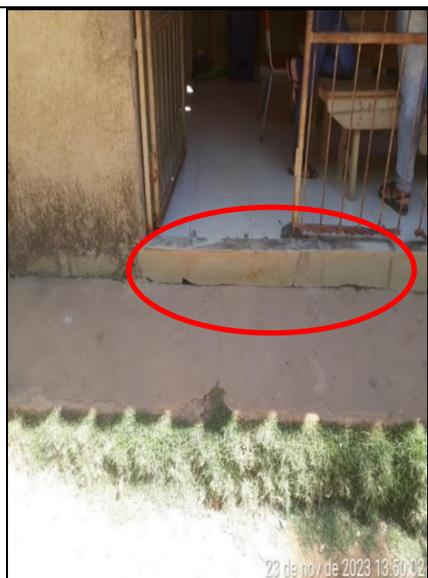
**Figura 192 - Detalhe do desnível entre parte interna e externa da entrada da escola**
