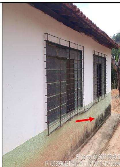
**Figura 55 - Detalhe de umidade na parede do lado externo**
