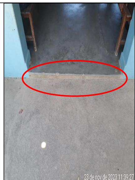
**Figura 191 - Detalhe do desnível existente entre o pátio interno e o externo**
