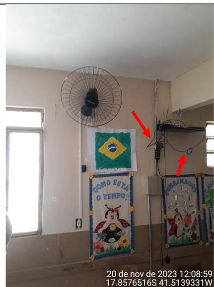
**Figura 32 - Detalhe de instalação elétrica aparente e com remendos**
