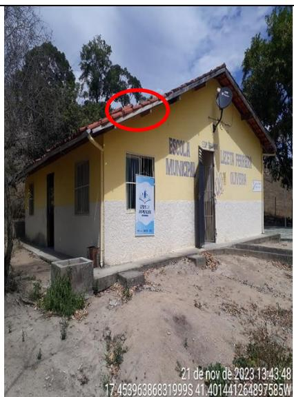
**Figura 84 - Detalhe de telhas soltas na cobertura**
