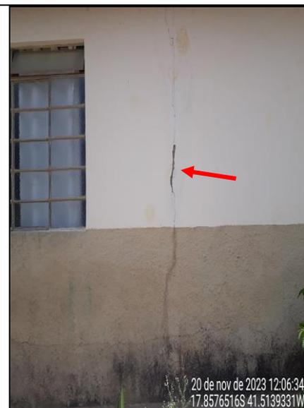
**Figura 29 - Detalhe de rachadura na parede lateral**
