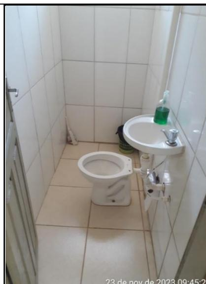
**Figura 172** - Detalhe de bacia sanitária sem assento
