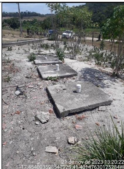
**Figura 82 - Detalhe das tampas das fossas sem proteções**
