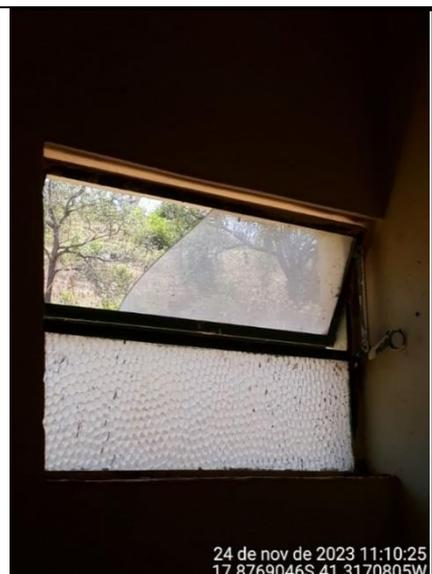
**Figura 230 - Detalhe de janela do banheiro com vidro quebrado**
