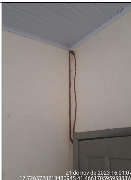
**Figura 109 - Detalhe de caminho de cupim na parede em direção ao madeiramento da cobertura**
