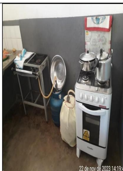
**Figura 151 - Detalhe da ausência de casa de gás GLP**
