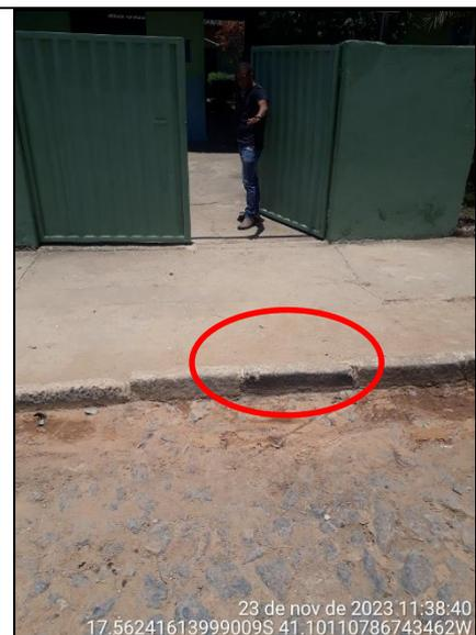
**Figura 186 - Detalhe da falta de rebaixamento do meio fio, frontal ao portão de entrada da escola, para construção de rampa acessível**
