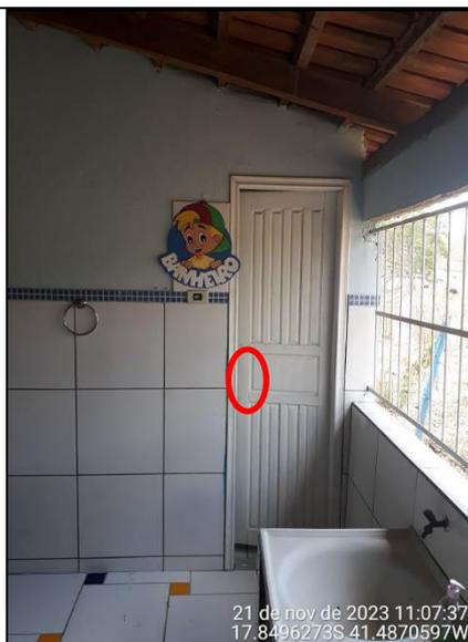
**Figura 70 - Detalhe de ausência de maçaneta e fechadura na porta do banheiro masculino**
