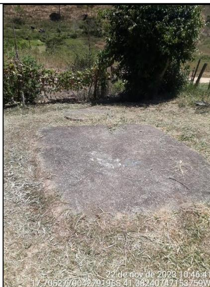
**Figura 133 - Detalhe da tampa da fossa sem proteção**
