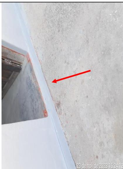
Figura 205 - Detalhe do desnível entre calçada e sala de aula
