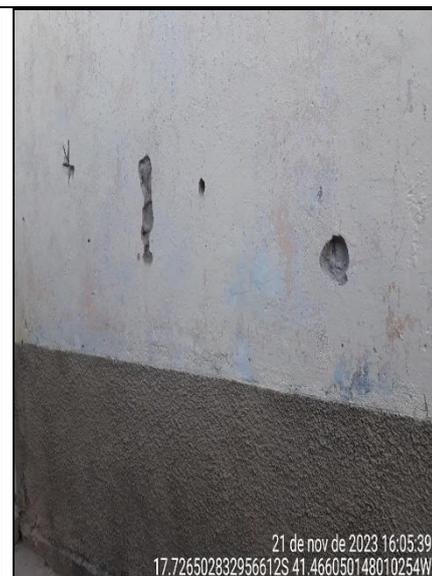
**Figura 110 - Detalhes de buracos na parede lateral**
