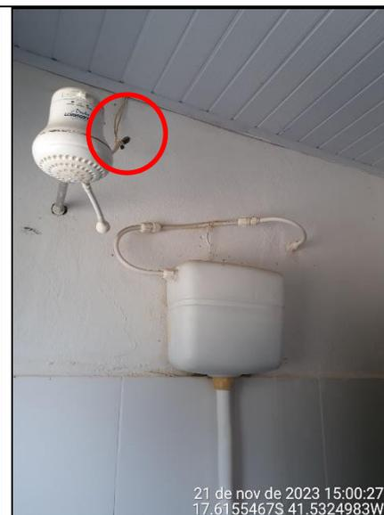
**Figura 95 - Detalhe de instalação elétrica aparente com remendo**
