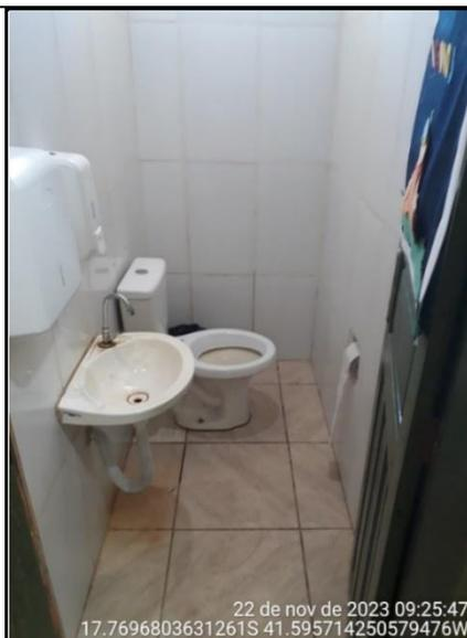
**Figura 115 - Detalhe de bacia sanitária sem assento**
