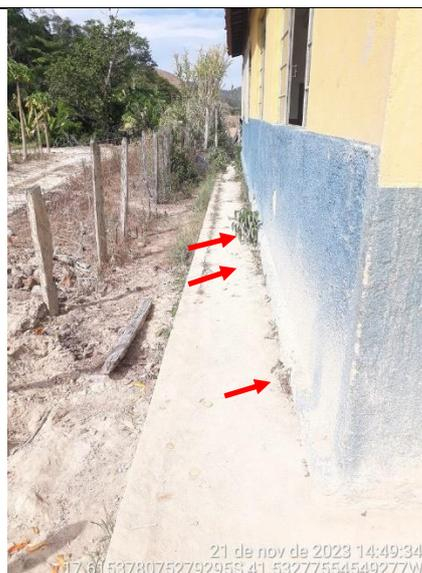
**Figura 91 - Detalhe da vegetação sobre calçada lateral**
