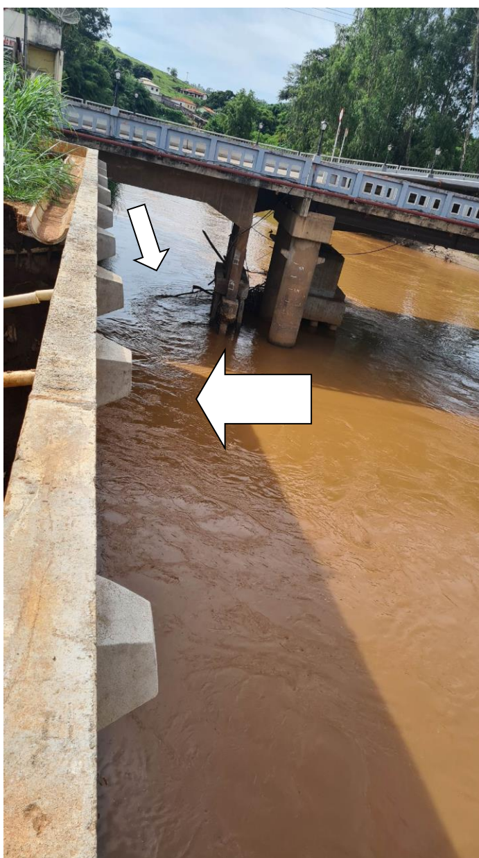
Foto 4 – Vórtex formado a partir da limpeza do apoio e do desassoreamento do vão inicial sob as OAES
