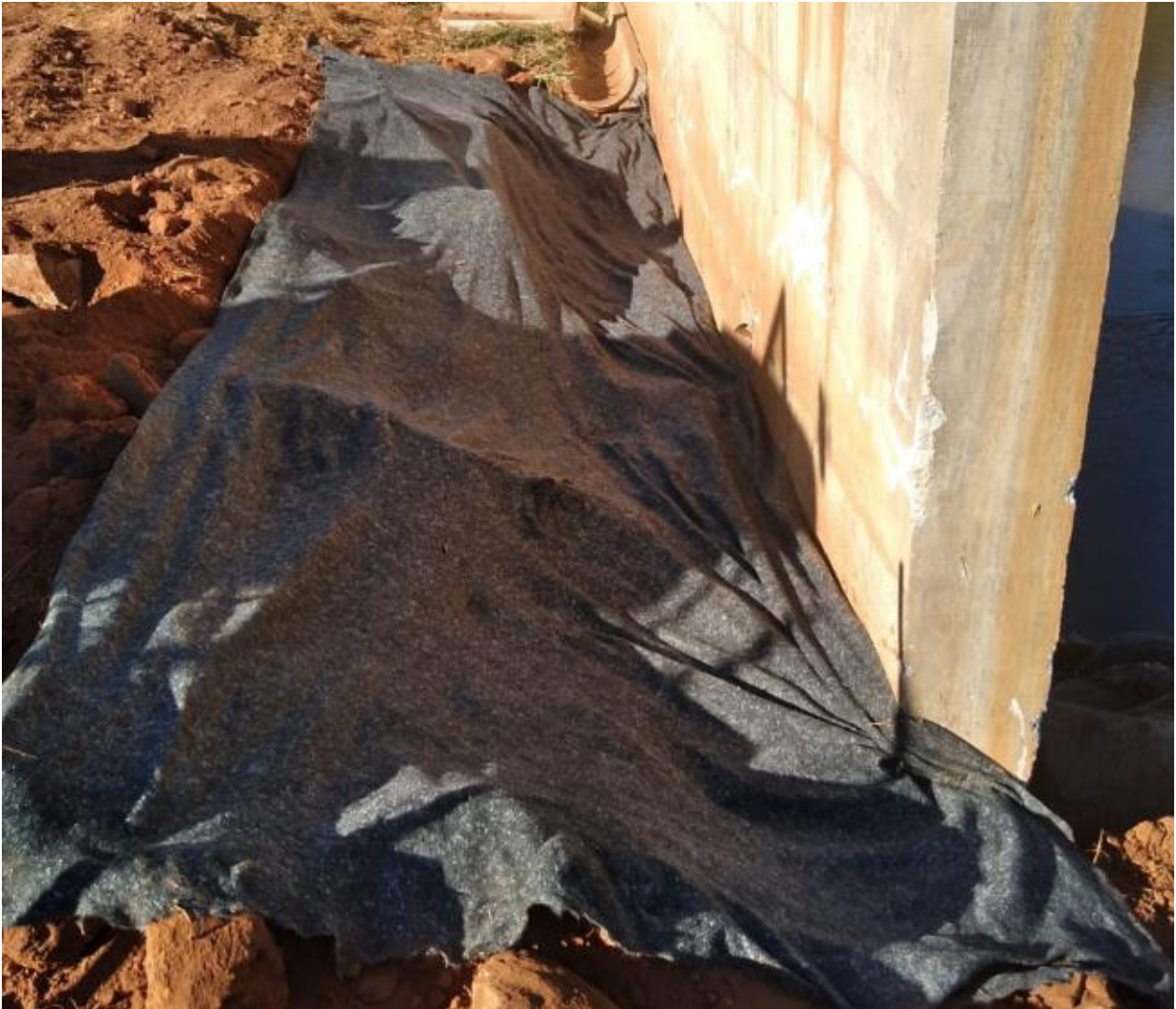
Foto 10 - Proteção com manta geotêxtil
