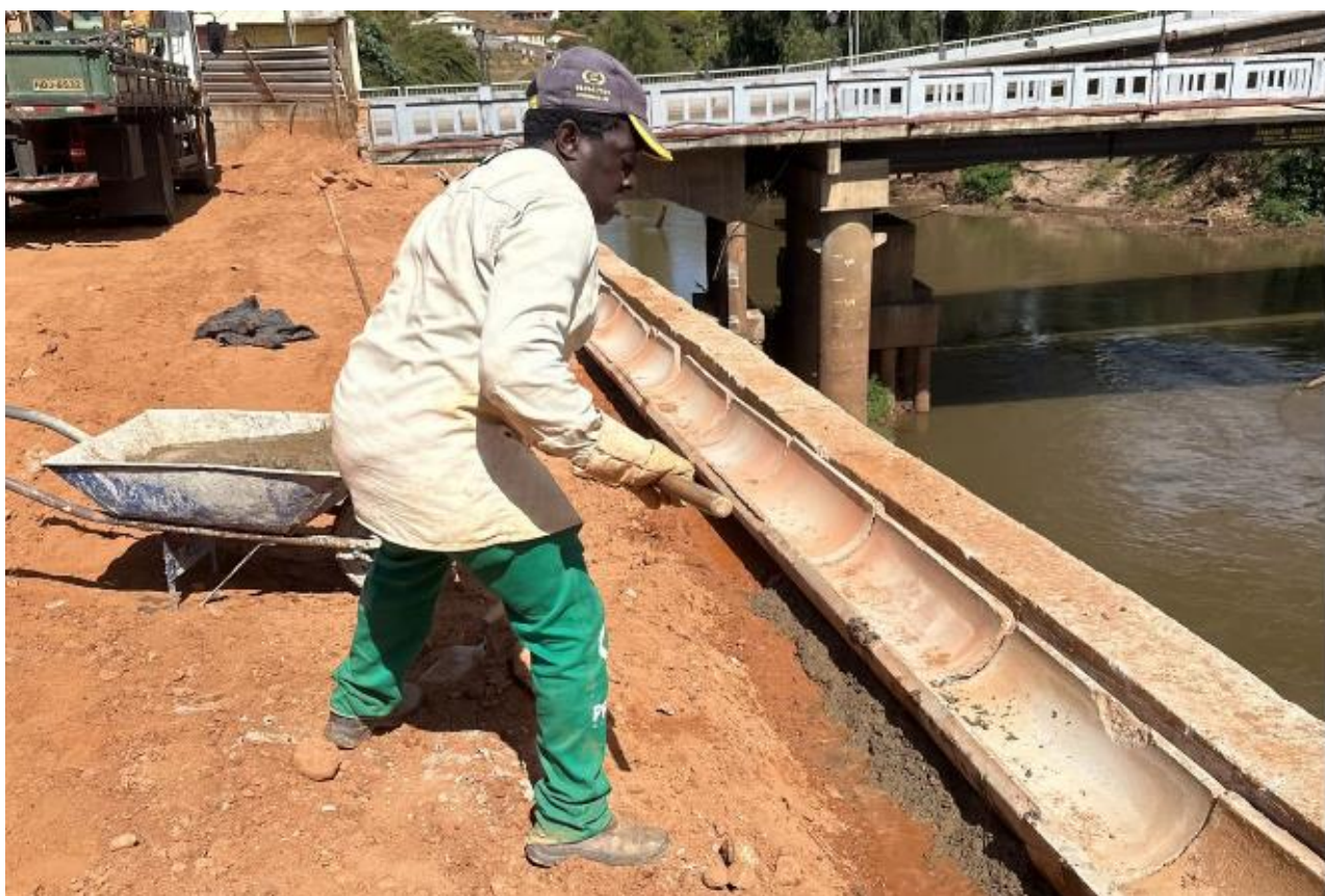
Foto 8 - Colocação de canaleta meia cana, para captação de condução da drenagem superficial
