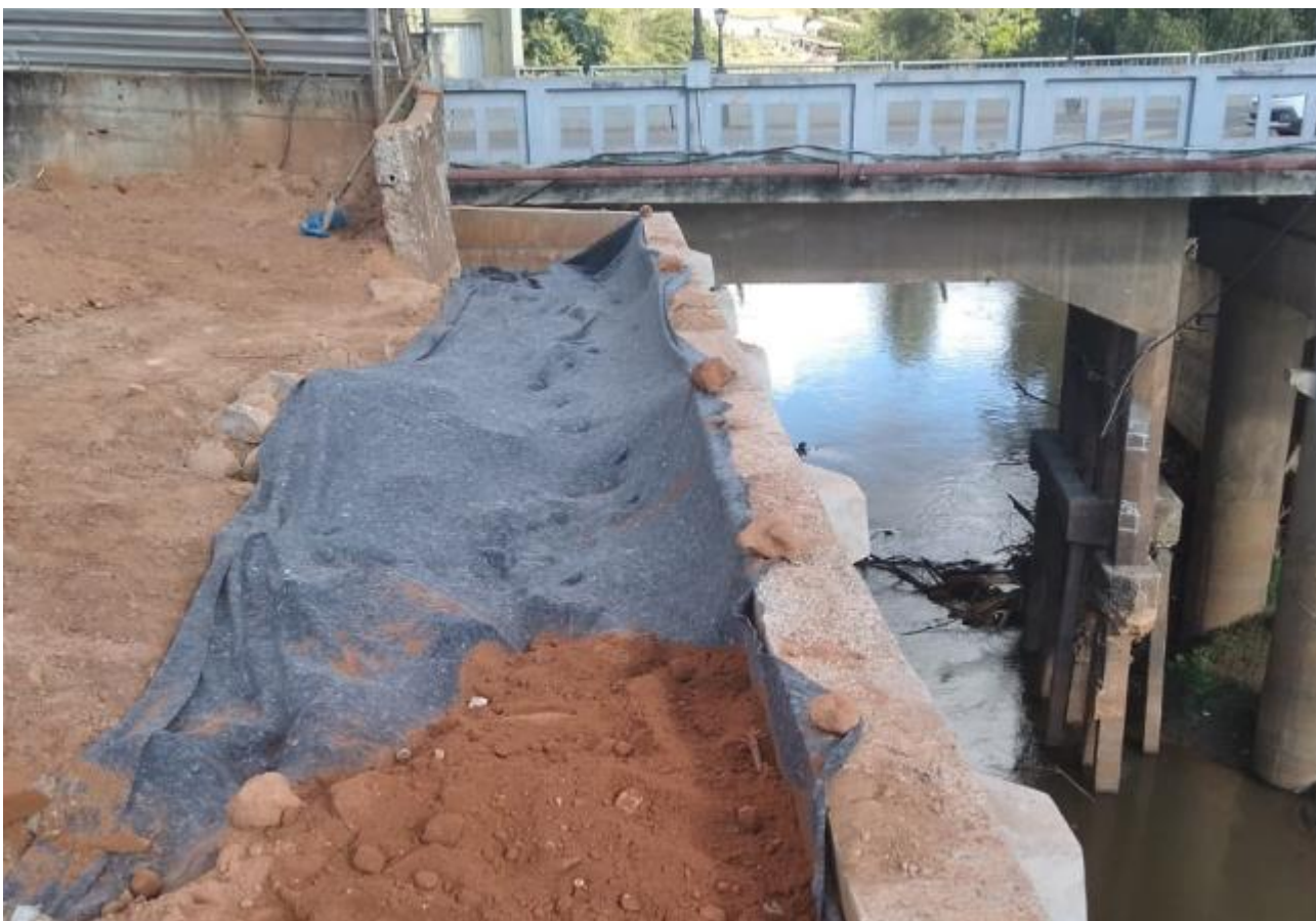
Foto 6 - Proteção com manta geotêxtil
