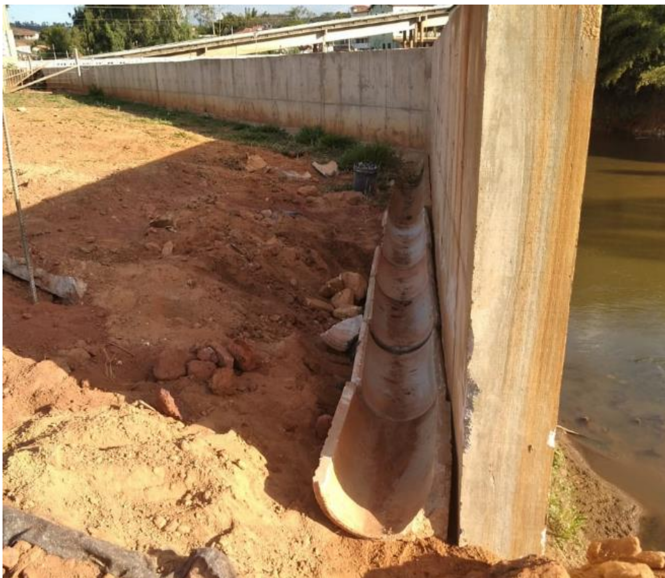
Foto 11 - Colocação de canaleta meia cana, para captação de condução da drenagem superficial
