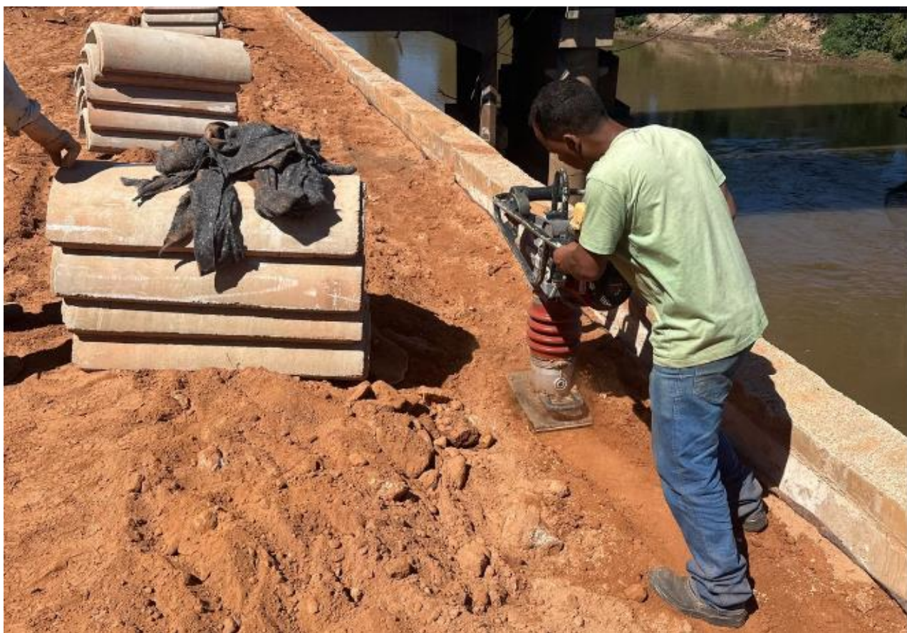
Foto 7 - Compactação manual da camada superficial do terrapleno
