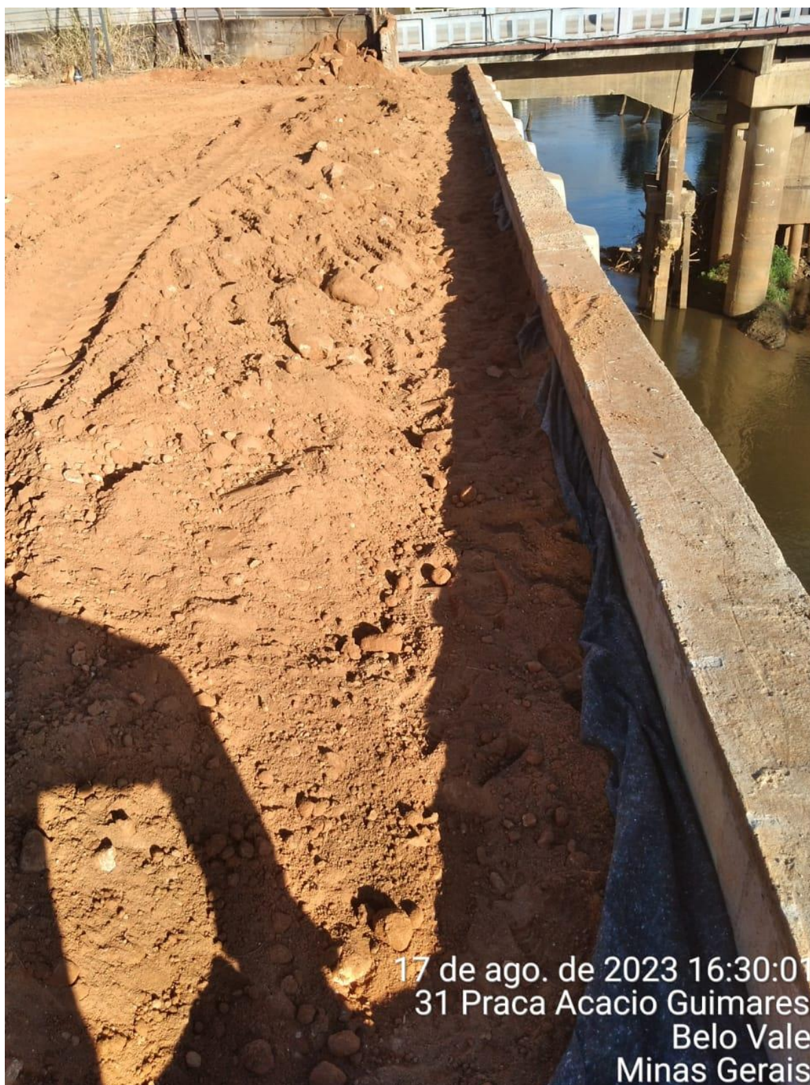
Foto 15 – Instalação de Manta Geotextil tipo bidim para compactação de solo
