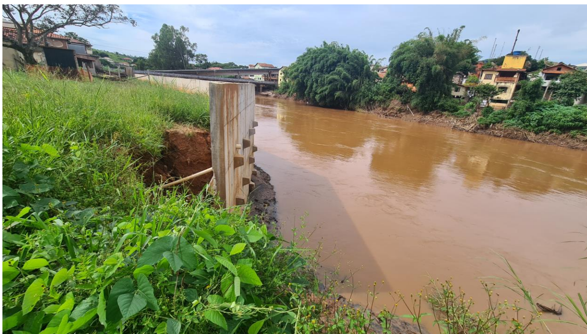
Foto 3 - Erosão no final da contenção
