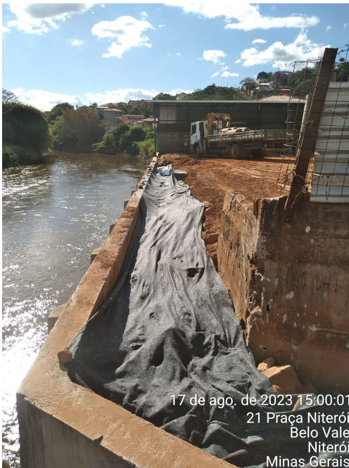
Foto 16 – Instalação de Manta Geotextil tipo bidim para compactação de solo e instalação de novas canaletas de drenagem
