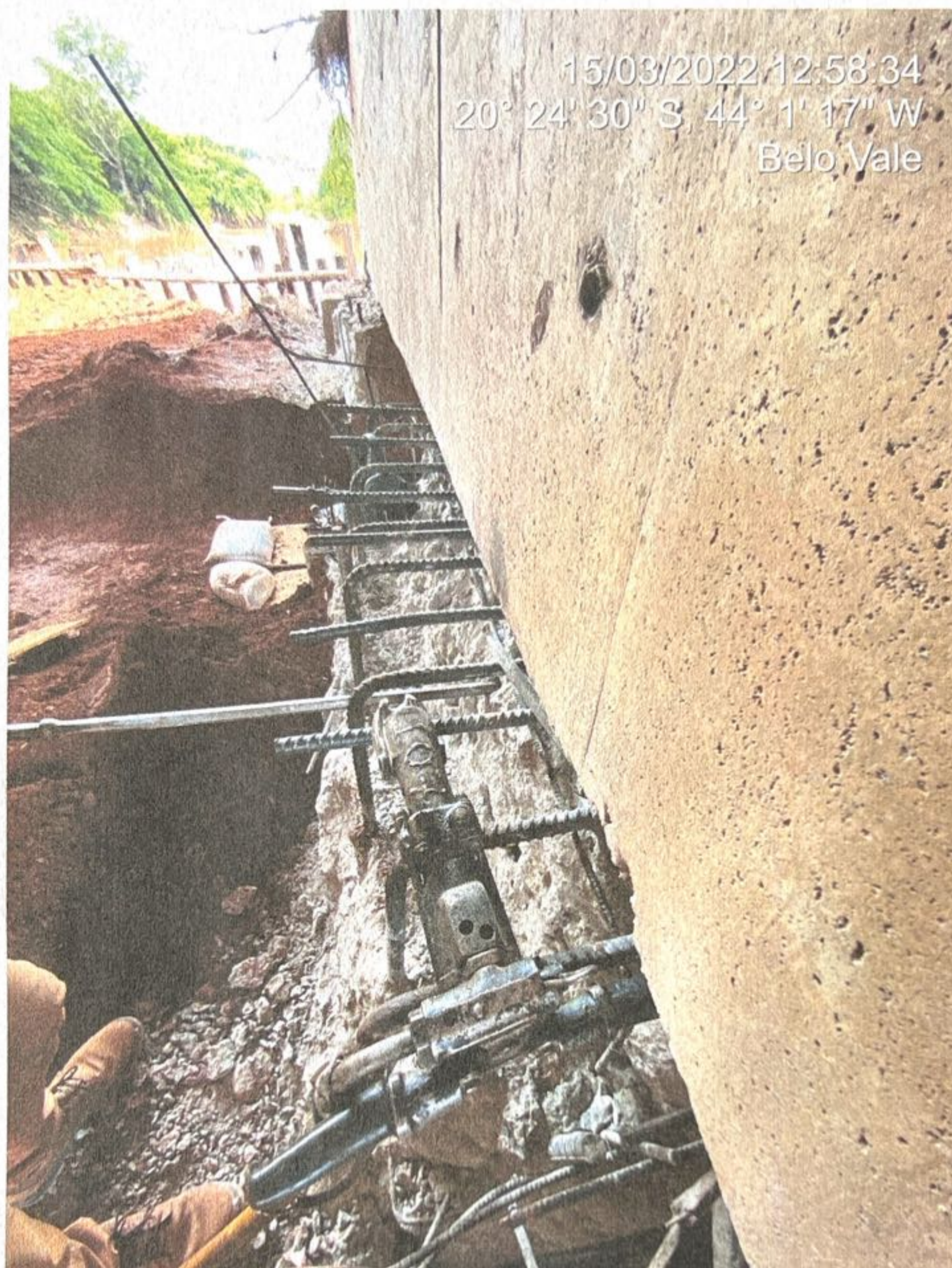
Foto 1 – Detalhe da tentativa de demolição do bloco existente – (mar/2022)
