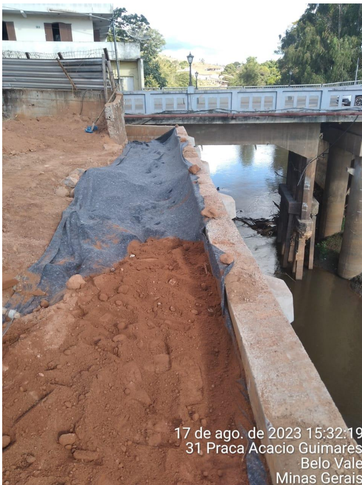
Foto 13 – Instalação de Manta Geotextil tipo bidim para compactação de solo
