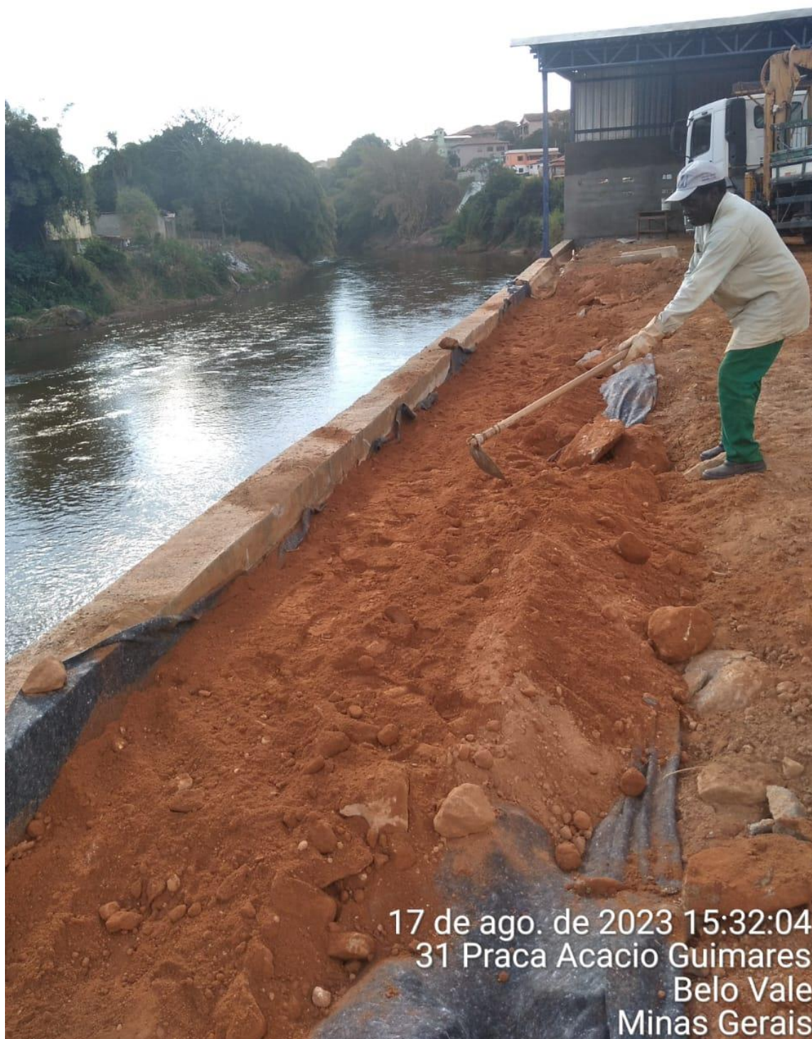
Foto 14 – Instalação de Manta Geotextil tipo bidim para compactação de solo
