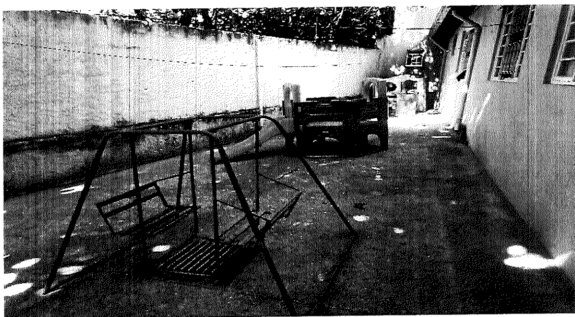
Figura 14 - Creche Oficina Escola Angelis – Trabalho de campo realizado em 10/04 – Piso com rachaduras e sem segurança para circulação de crianças no parque infantil da UEI devido a muro de arrimo comprometido.
