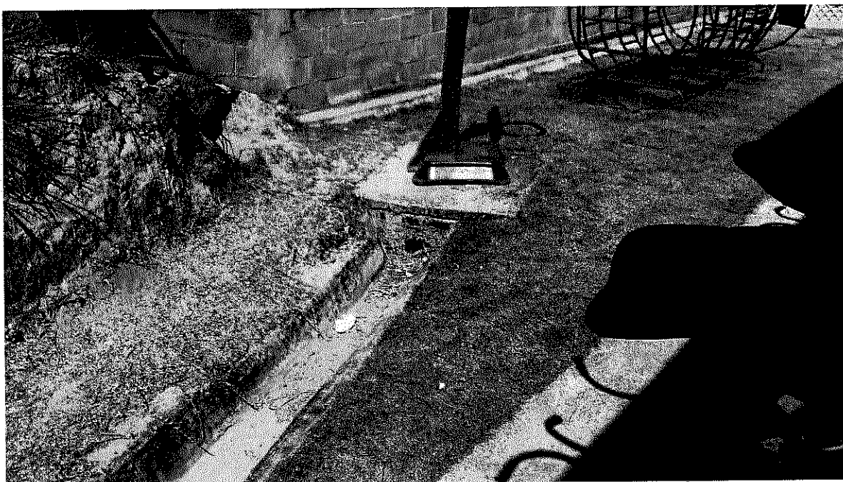
Figura 5- UMEI Manacás – Trabalho de campo realizado em 17/04 – Área externa com calha de água pluvial aberta muito próxima à passagem e aos brinquedos, não oferecendo segurança.
