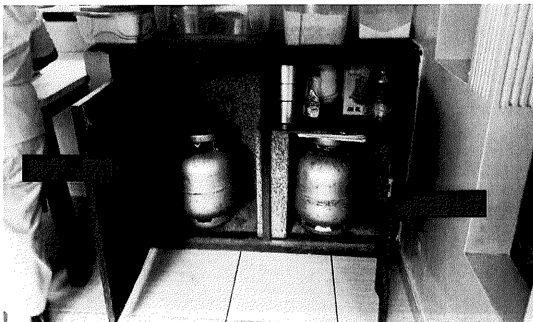
Figura 47 - Creche do Conselho Comunitário Integração de Venda Nova- Trabalho de campo realizado em 20/04 – Cozinha com botijão de gás muito próximo ao forno e botijões de gás acondicionados no interior de armários entre o refeitório e a cozinha, em ambiente fechado e sem ventilação.
