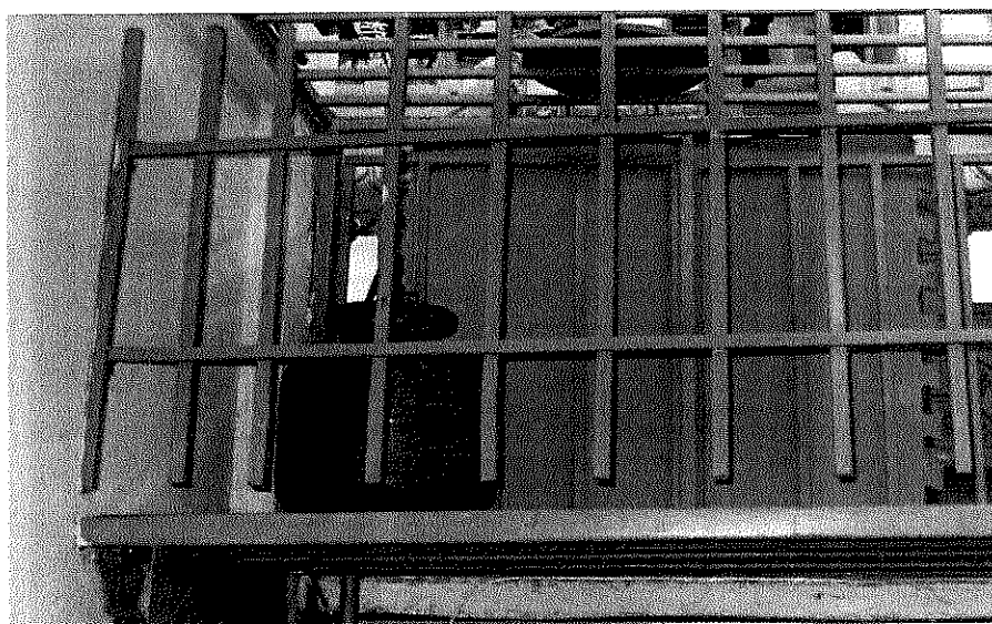
Figura 51 - Creche Grupo de Amigos da Criança – Trabalho de campo realizado em 04/04 – Botijão de gás instalado suspenso, na área central da escola, sobre a passagem de usuários (crianças e adultos) e sem proteções nas laterais/fundo adequadas.
