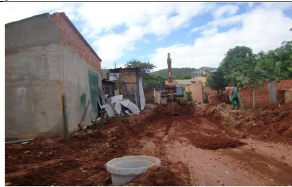
Rede de 600mm substituída por de 1500mm – removida e demolida
