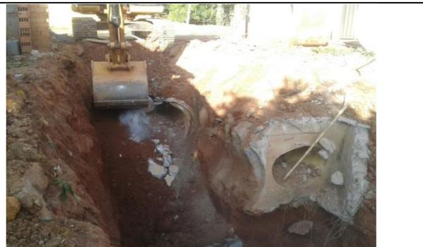
Caixas de passagem existentes (PVs) demolidos e removidos.
