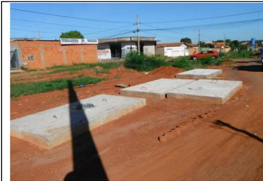
Tampas em concreto armado das caixas executadas e colocadas, removidas e demolidas
