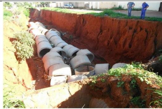
Rede 1.500mm executado pela prefeitura, removida e demolida para implantação de galeria de concreto
