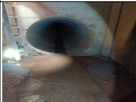
Foto 11 – Vista da rede tubular diâm – 1,50m – Encontro/saída em caixa de inspeção – Altura da rua João P Barbosa
