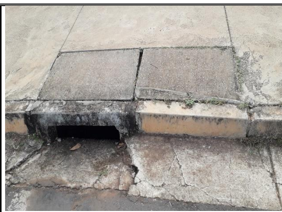
Foto 34 - Vista boca de lobo simples construída
