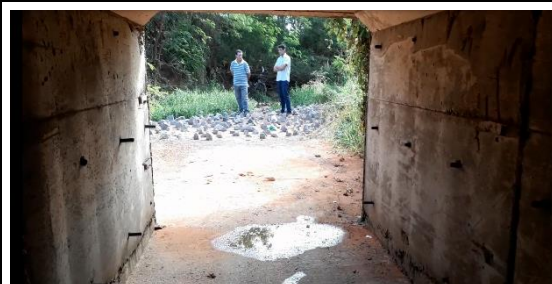
Foto 20 – Vista interna da chaminé de poço de visita na galeria de 1,80m – próxima ao dissipador de energia
