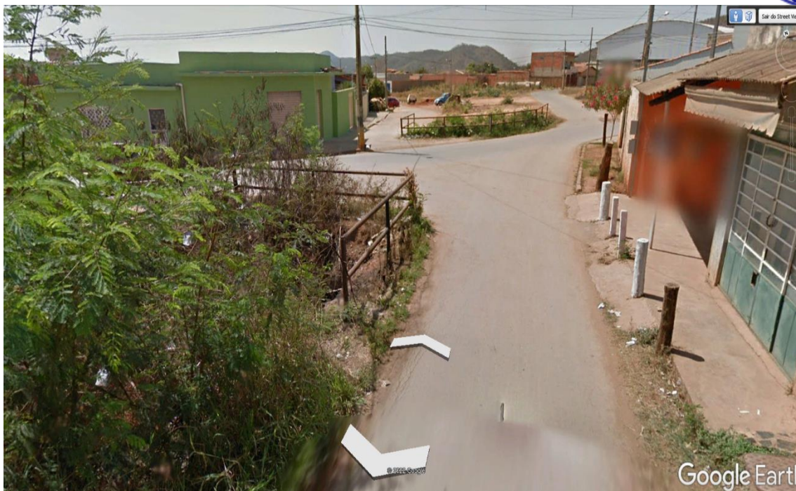
Imagem 17 - Vista parcial de passagem existente onde a rede/galeria foi construída – imagem ano de 2013 Google Earth
