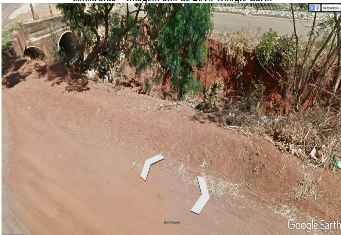
Imagem 18 - Vista parcial de passagem existente onde a rede/galeria foi construída – imagem ano de 2013 Google Earth
