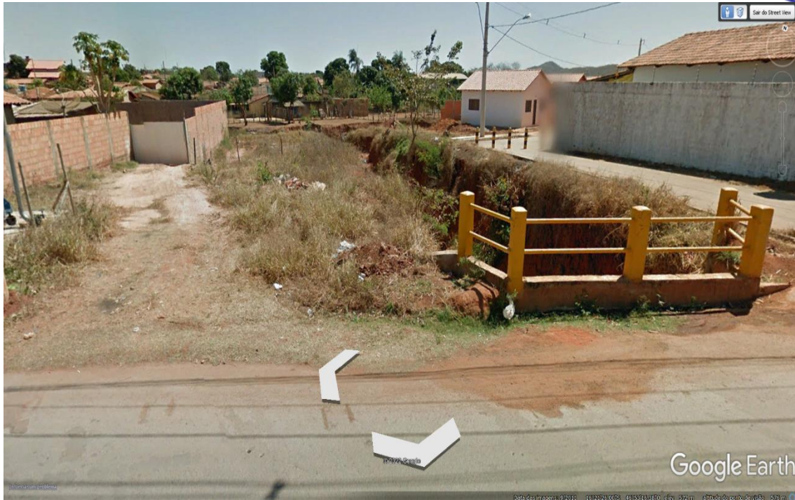
Imagem 23 - Vista parcial de passagem existente onde a rede/galeria foi construída – imagem ano de 2013 Google Earth
