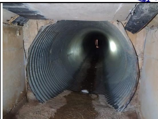
Foto 16 – Detalhe de encontro da galeria 1,65 com passagem em tubo ARMCO – Altura da rua Roraima
