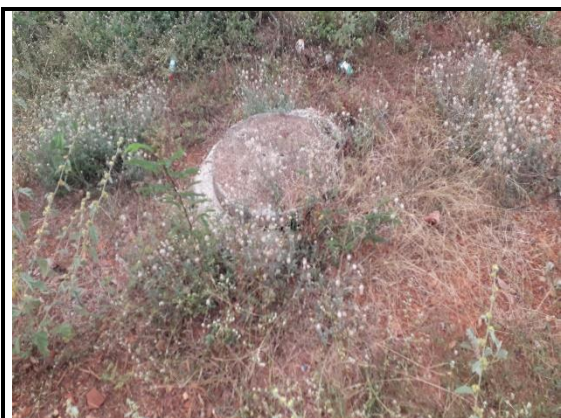
Foto 35 - Vista de poço de visita – PV
