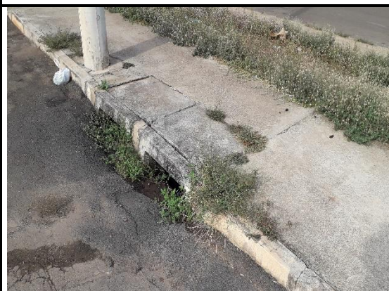
Foto 32 - Vista boca de lobo dupla construída
