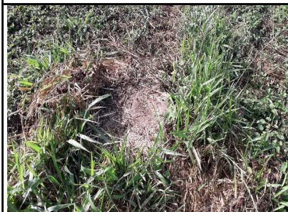
Foto 31 - Vista de bueiro no canteiro central – Início das obras
