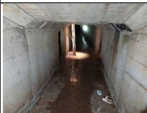
Foto 18 – Interior da galeria de 1,80m – Ao fundo iluminação proveniente da abertura da tampa do poço de visita e escada de acesso.
