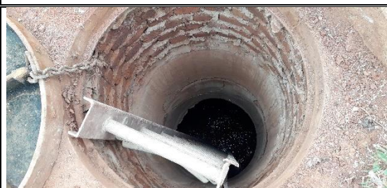
Foto 13 – Detalhe da chaminé do poço de visita – chaminé e alteamento.
