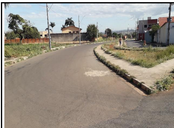
Foto 29 – Ponto de partida da obra – rede tubular pluvial diâmetro 1,50m
