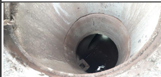
Foto 8 – Chaminé e fundo da caixa de inspeção – altura da rua João P Barbosa
