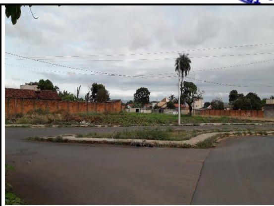
Foto 30 – Ponto de partida da obra – rede tubular diâmetro 1,50m
