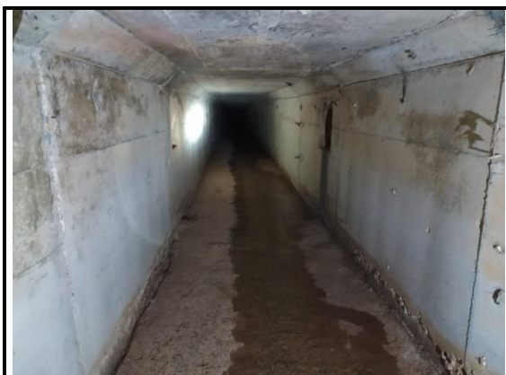
Foto 15 – Interior da galeria de 1,65 m
