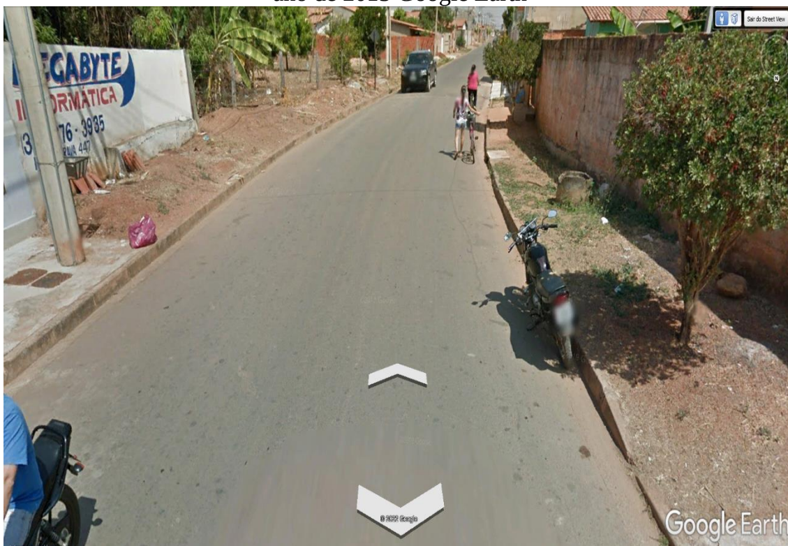
Imagem 4 - Vista parcial onde a rede/galeria pluvial foi construída – imagem ano de 2013 Google Earth
