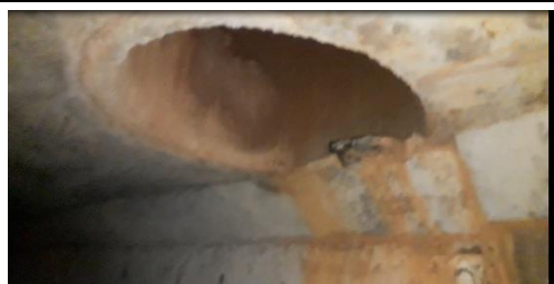
Foto 19 – Vista interna da chaminé de poço de visita de na galeria de 1,80m – próxima ao dissipador de energia.
