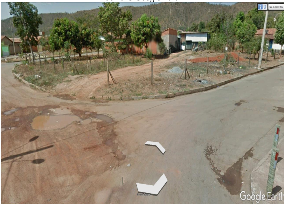
Imagem 6 - Vista parcial onde a rede/galeria pluvial foi construída – imagem ano de 2013 Google Earth
