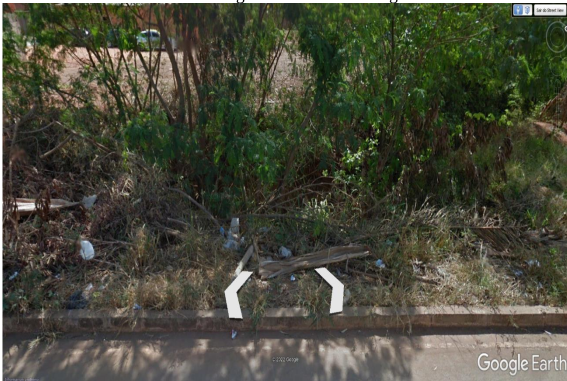
Imagem 24 - Vista parcial da grotá onde a rede/galeria foi construída – imagem ano de 2013 Google Earth
