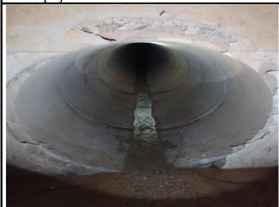
Foto 10 - Vista interna da rede tubular diâm 1,50m – Encontro/chegada em caixa de inspeção – Altura da rua João P Barbosa
