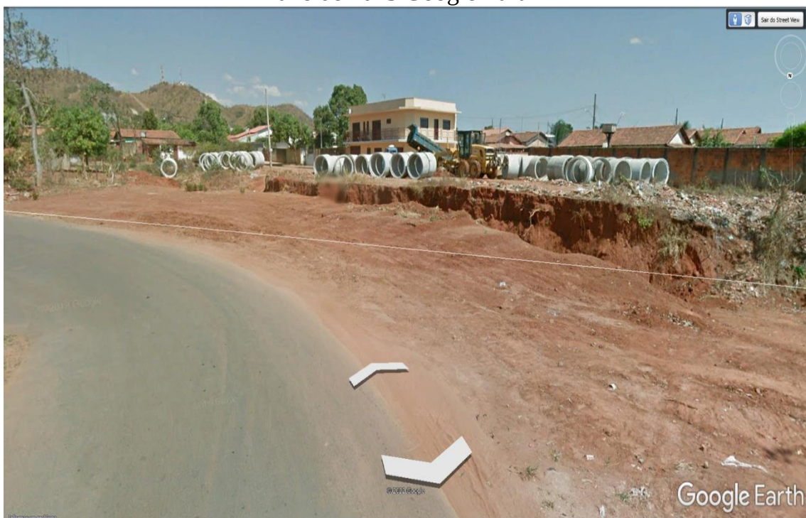
Imagem 8 - Vista parcial do início da grota onde a rede/galeria foi construída – imagem ano de 2013 Google Earth
