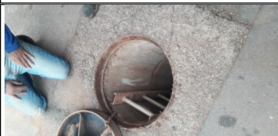
Foto 9 – Acesso para a caixa de inspeção – altura da rua João P Barbosa.
