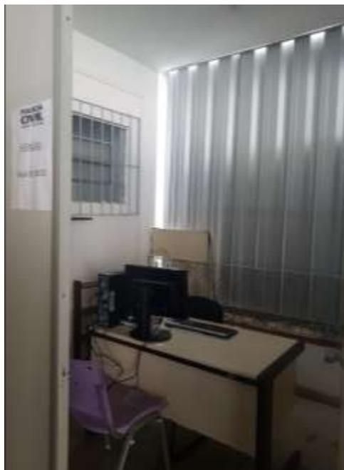
**Figura 9: Sala de Registro de Eventos de Defesa Social (REDS) possui fechamento lateral com telha metálica que não oferece conforto térmico e acústico**
