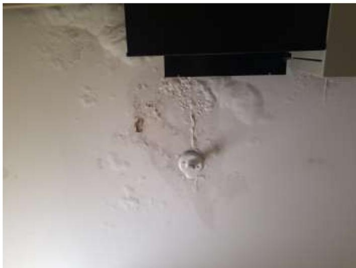
**Figura 7: Infiltração na laje de uma das salas da DEAM**
