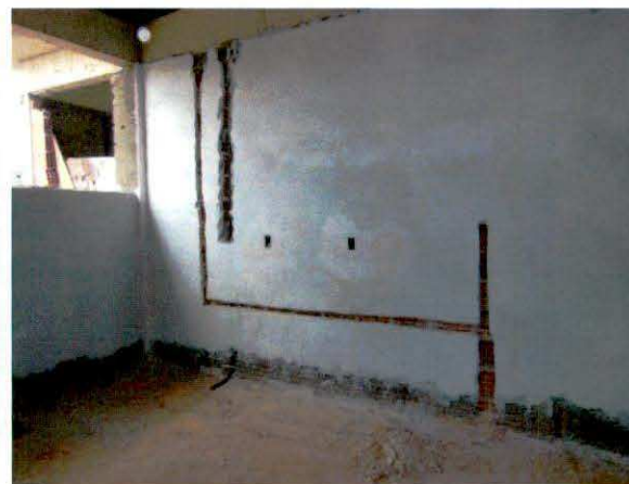
PC-7.3.10 - Cortes para instalação hidráulica
