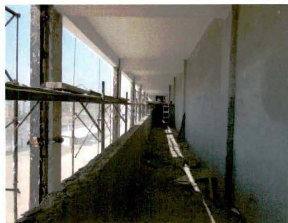
PC-7.1.16 - Laje revestida e emassada
