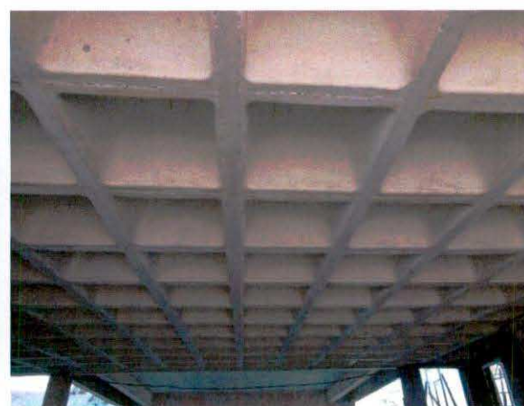
PC-7.1.18 - Laje nervurada (transição)
