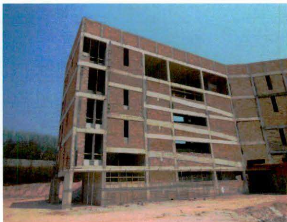
PC-7.1.4 - Fachada posterior (transição)
