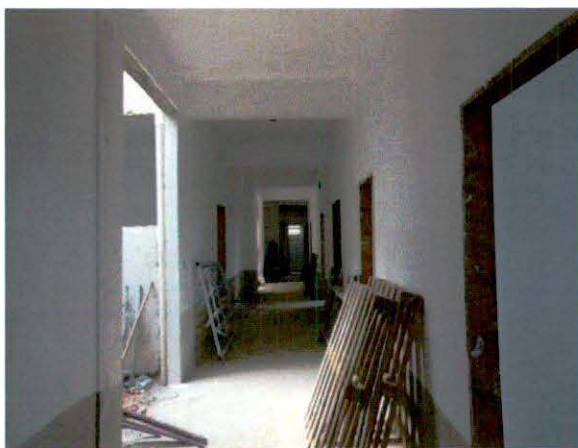
PC-7.2.5 - Interior com emassamento
