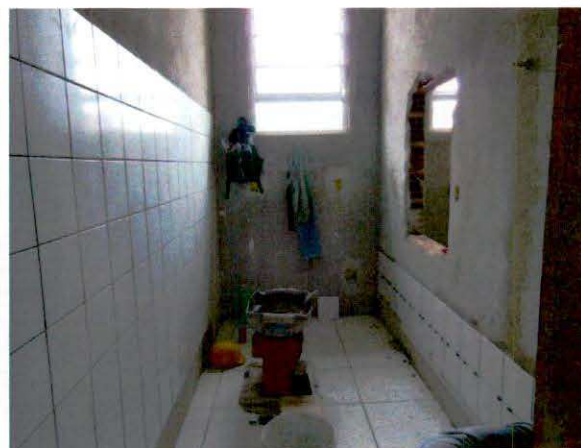
PC-7.2.6 - Assentamento de cerâmica
