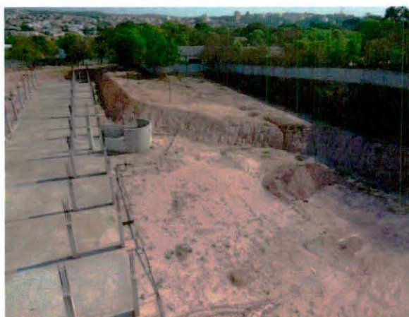
PC-7.1.11 - Escavação do auditório
