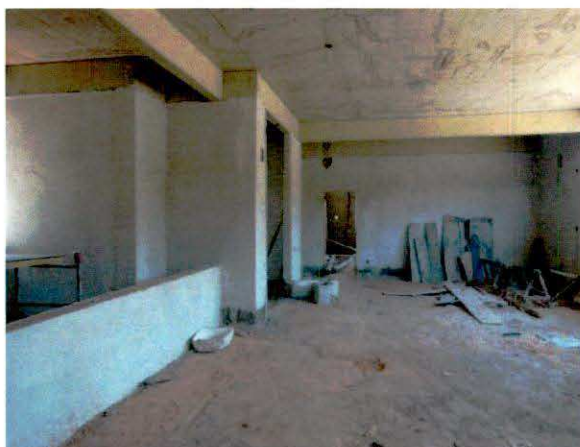
PC-7.3.5 - Interior com alvenaria rebocada
