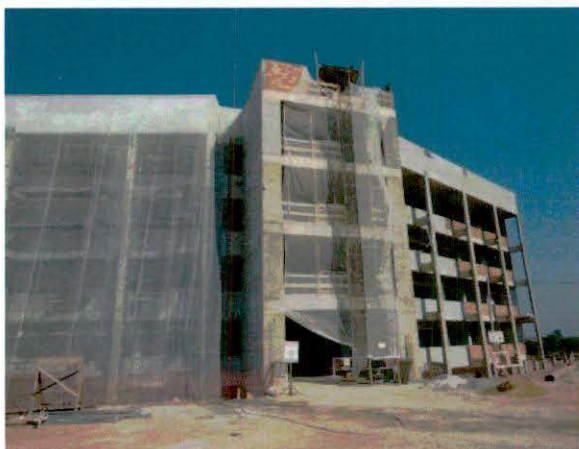
PC-7.1.3 - Fachada frontal (transição)
