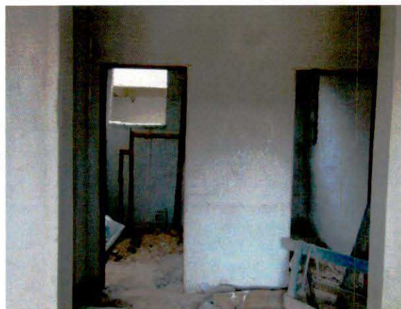
PC-7.3.6 - Cômodos ainda sem o revestimento cerâmico
