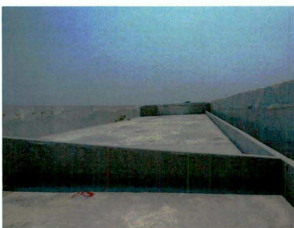
PC-7.1.17 - Laje de cobertura (5º andar)
