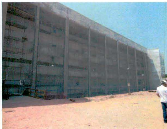
PC-7.1.2 - Fachada frontal (centro)
