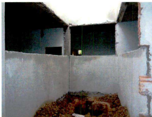
PC-7.3.7 - Escavação para drenagem pluvial
