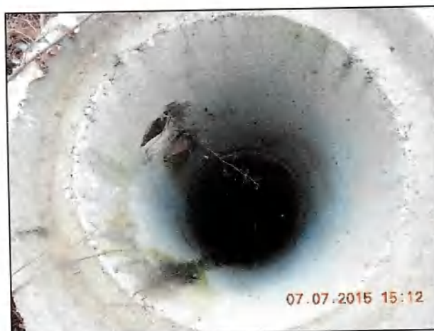
PC-7.0 – Manilhamento p/drenagem Junto ao hospital (DSCN0016)
