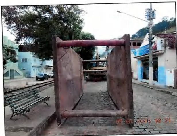
PC-7.0 – CONTENÇÃO DE ENCOSTAS E DRENAGEM R. Adão Araújo (DSCN0037)
