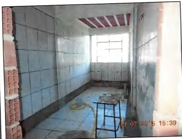
PC-7.3 – Banheiro em reforma (DSCN0154)
