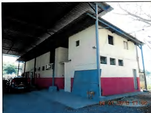
PC-7.4 – local utilizado como canteiro (DSCN0128)
