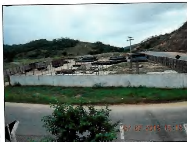
PC-7.0 – Manilhamento p/drenagem Junto ao hospital (DSCN0019)
