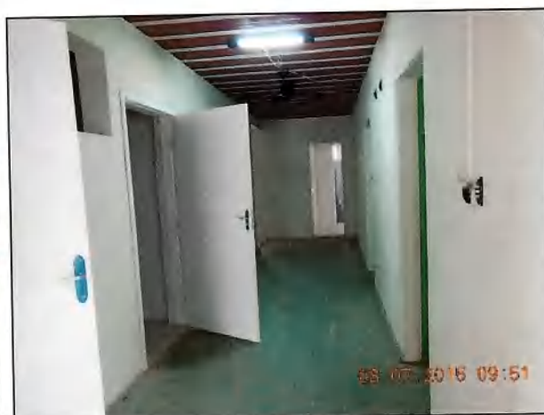
PC-7.0 – UBS Marinópolis – Ampliação e Reforma (DSCN0062)
