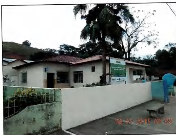
PC-7.0 – UBS Marinópolis – Ampliação e Reforma (DSCN0061)
