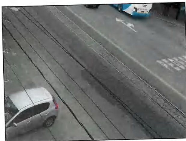
PC-7.0 – RECUPERAÇÃO DE PAV. ASFÁLTICA Pça. Cel. Breves (DSCN0001)
