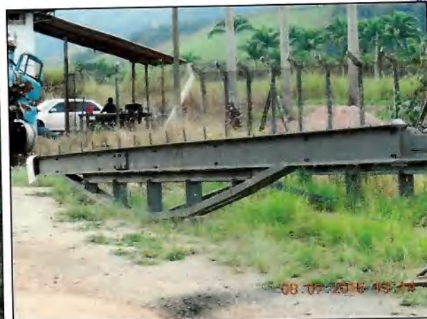
PC-7.0 – Cabeceira de pontes - vigas Marinópolis (DSCN0071)
