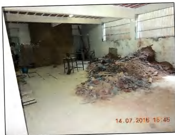
PC-7.3 – Material do deslizamento a ser retirado (DSCN0057)
