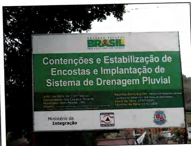
PC-7.0 – Contenção de encostas e drenagem Lad Dr Paulo Fonseca (DSCN0031)
