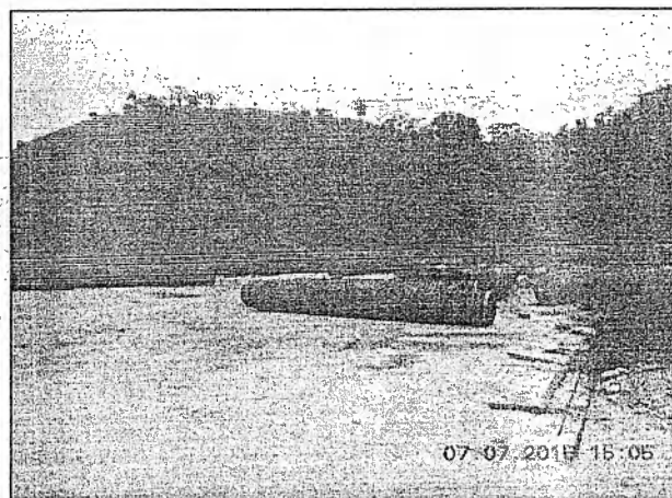
PC-7.0 – Contenção de encostas e drenagem Material estocado (DSCN0010)
