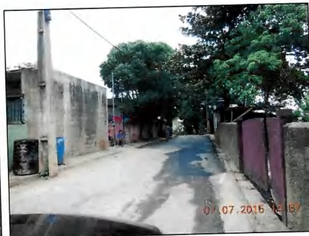
PC-7.0 – RECUPERAÇÃO DE PAV. ASFÁLTICA Bairro Goiabal (DSCN0006)
