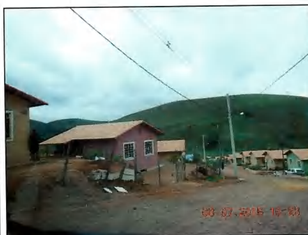
PC-7.0 – Terraplenagem COHAB (DSCN0074)
