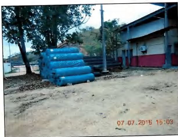
PC-7.0 – Contenção de encostas e drenagem Material estocado (DSCN0008)
