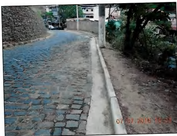
PC-7.0 – CONTENÇÃO DE ENCOSTAS E DRENAGEM R. Dr. Paulo Fonseca (DSCN0046)
