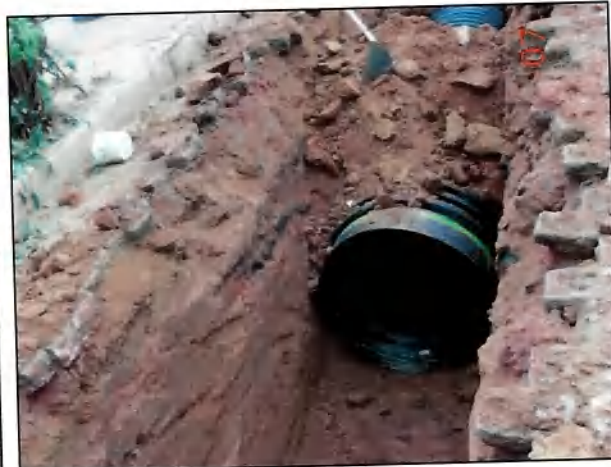
PC-7.0 – CONTENÇÃO DE ENCOSTAS E DRENAGEM R. Adão Araújo (DSCN0041)
