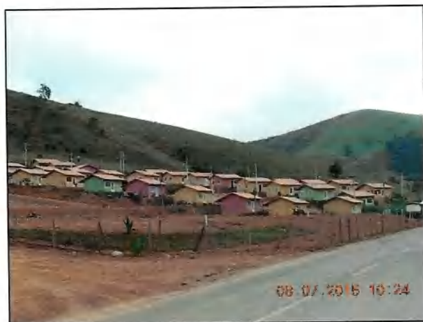
PC-7.0 – Terraplenagem COHAB (DSCN0072)
