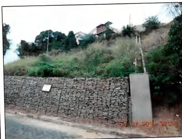
PC-7.0 – CONTENÇÃO DE ENCOSTAS E DRENAGEM R. Dr. Paulo Fonseca (DSCN0049)
