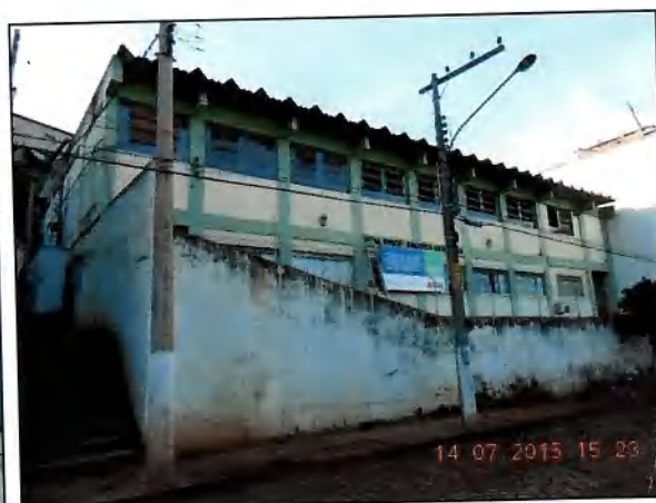
PC-7.3 – Fachada frontal (DSCN0130)
