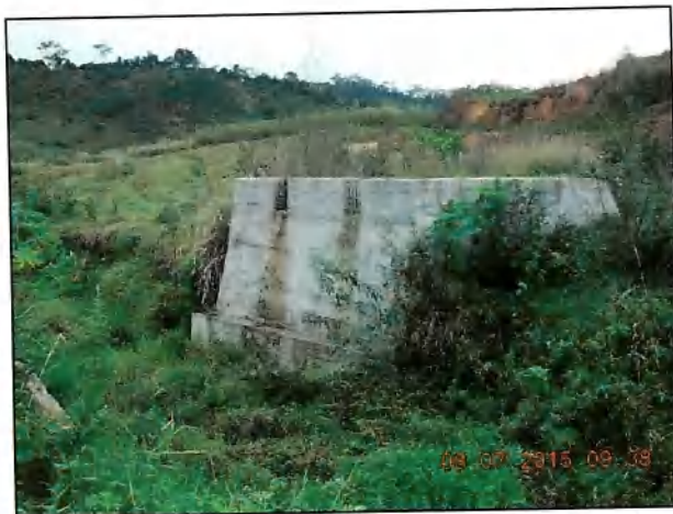
PC-7.0 – Cabeceira de pontes Marinópolis (DSCN0057)
