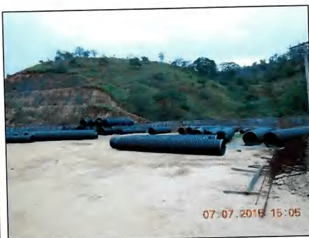
PC-7.0 – Contenção de encostas e drenagem Material estocado (DSCN0010)
