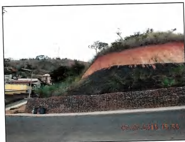
PC-7.0 – Contenção de encostas e drenagem Lad. Dr. Paulo Fonseca (DSCN0029)
