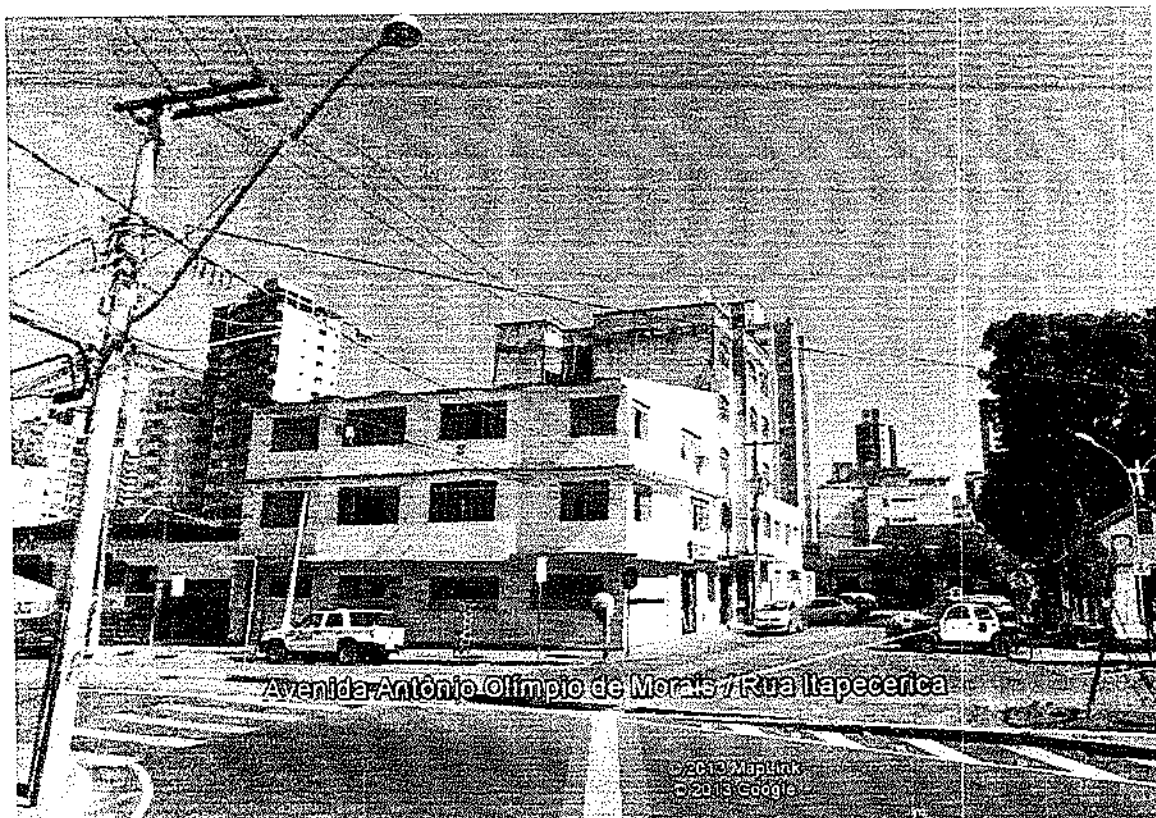
Imagem 02: Vista da edificação pela Rua Antônio Olímpio de Moraes - Fonte: Google Earth.
