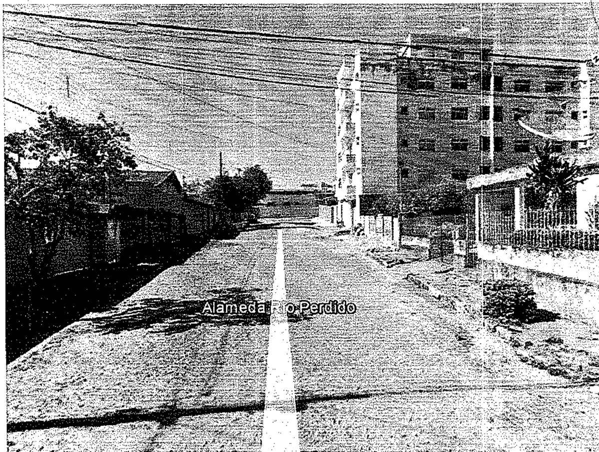
Imagem 03: Vista pela Alameda Rio Perdido - Fonte: Google Earth.
