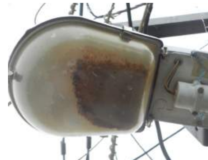
Figura 6.1 – Refratores danificados
