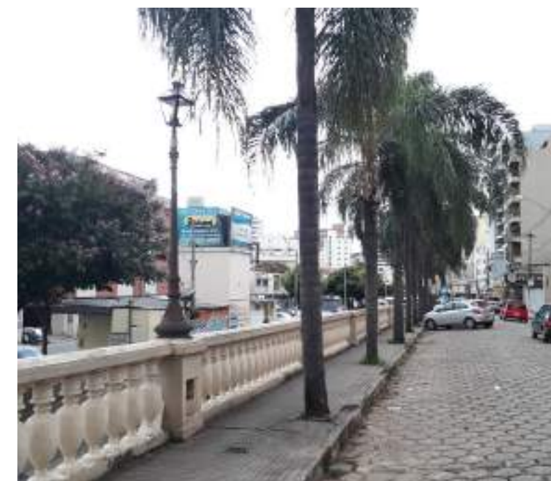
Figura 6.2 – Vista do lampião colonial da balaustrada com lâmpada VS 100 W
