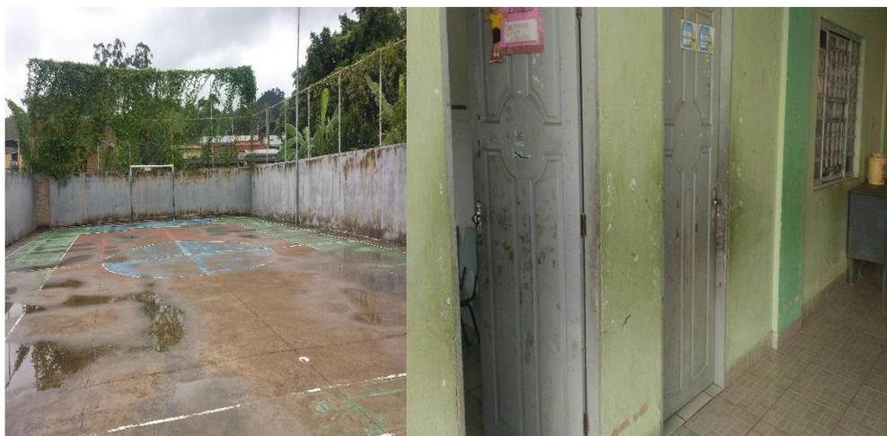
Figura 3: Fotos da EM Jorge Moreira Guillarducci. Trabalho de campo em 21/11/2017 - Área externa com a pintura das paredes internas e externas descascadas. Fonte: TCE/MG
