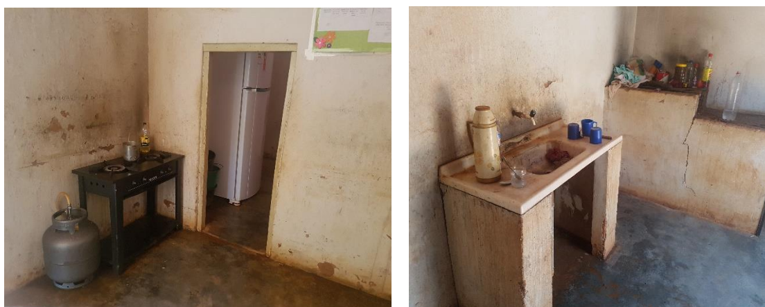
Figura 31: Fotos da EM Olavo Bilac. Botijão na área interna da cozinha e material de limpeza e alimentos acondicionados juntos. Trabalho de campo em 22/11/2017 Fonte: TCE/MG
