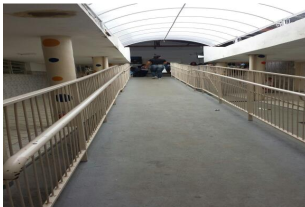
Figura 16: Fotos da EM João XXIII. Rampa de acesso para deficientes. Trabalho de campo em 23/11/2017 - Fonte: TCE/MG
