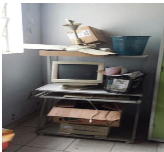
Figura 4: Fotos da EM Coronel Cláudio Gomes, zona rural. Armários danificadas e desorganizados. Trabalho de campo em 24/11/2017 - Fonte: TCE/MG
