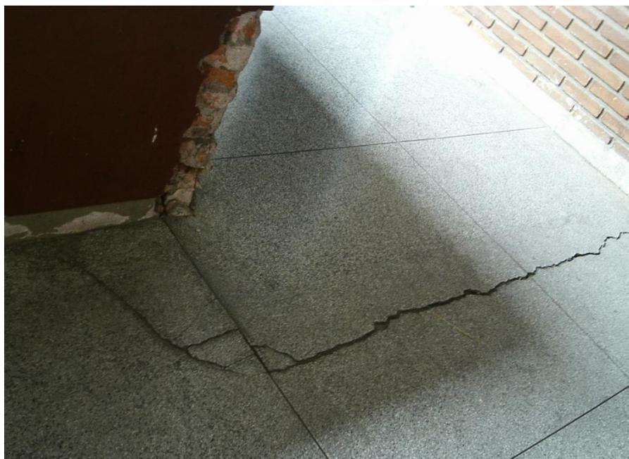
**Figura 7 – Rachadura no piso a partir da sala interditada no pavimento superior**
