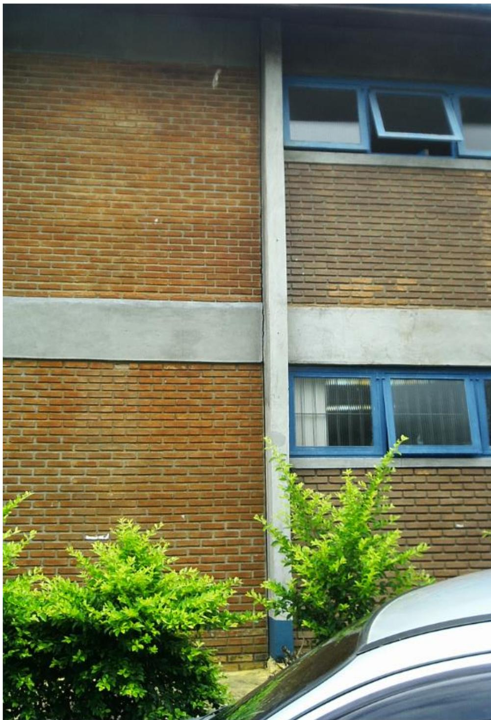
**Figura 5 – Visão externa da fresta em sentido vertical entre as paredes**
