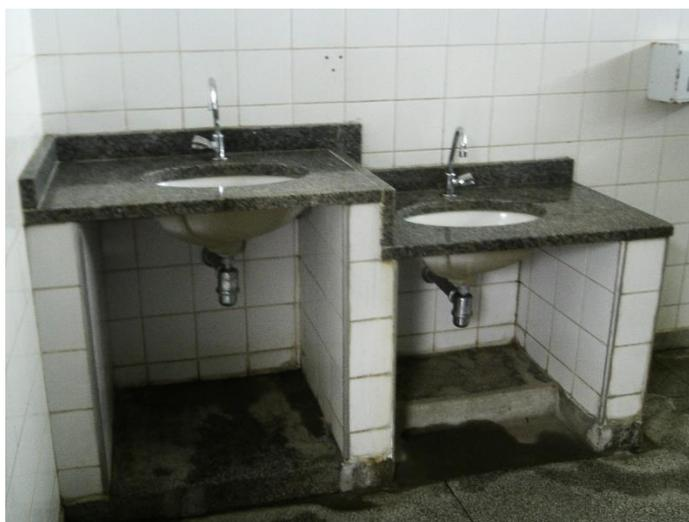
**Figura 39 - Pias com vazamentos**
