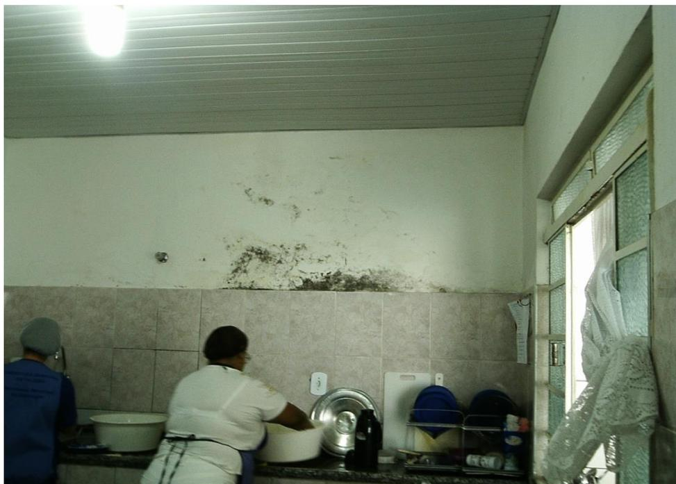
**Figura 54 – Parede mofada nos fundos da cozinha**
