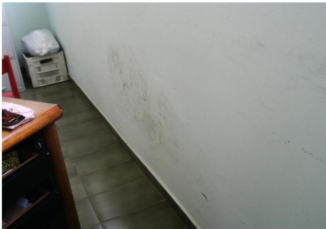
**Figura 55 – Sinais de infiltração na Sala da Direção**
