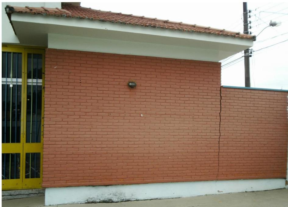
**Figura 63 – Rachadura no muro da escola**
