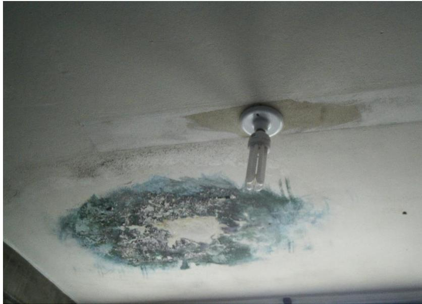
**Figura 37 – Infiltração no teto da sala de diretoria**
