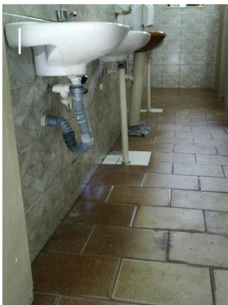
**Figura 16 - Banheiro com vazamentos e piso danificado**
