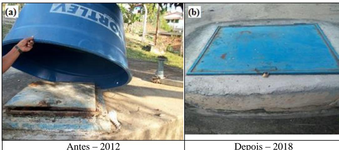
Figura 8 – Reservatório de água – reparo da tampa.
