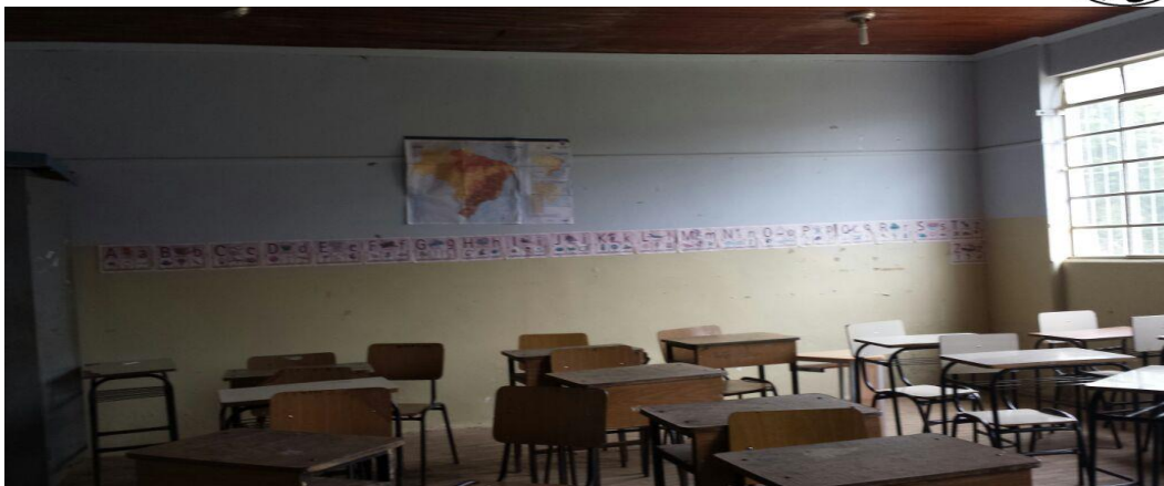
Figura 6: Fotos da Escola Municipal Coronel Cláudio Gomes, Zona rural. Carteiras dos alunos bastante danificadas. Trabalho de campo em 24/11//2017 - Fonte: TCE/MG
