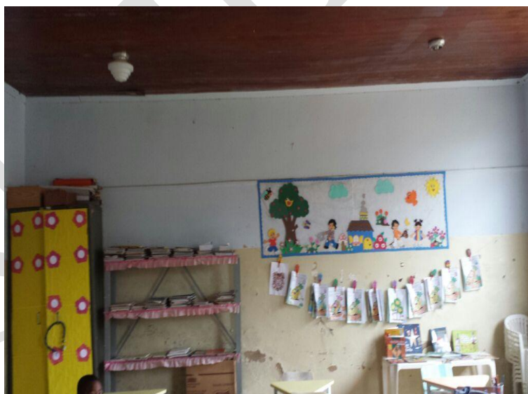
Figura 19: Fotos da EM Cláudio Gomes, zona rural. Trabalho de campo em 24/11/2017- - Fonte: TCE/MG.
