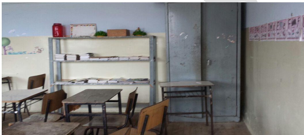
Figura 7: Fotos da Escola Municipal Coronel Cláudio Gomes, Zona rural. Carteiras dos alunos danificadas e armários enferrujados. Trabalho de campo em 24/11//2017 - Fonte: TCE/MG
