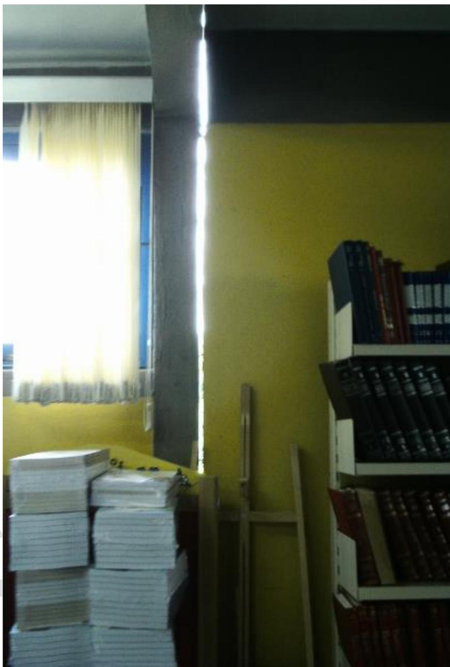
**Figura 8 – Visão interna da fresta na sala de leitura do pavimento inferior**
