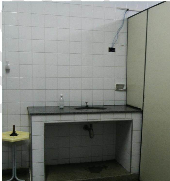
**Figura 38 – Vazamento e fios expostos no banheiro dos professores**
