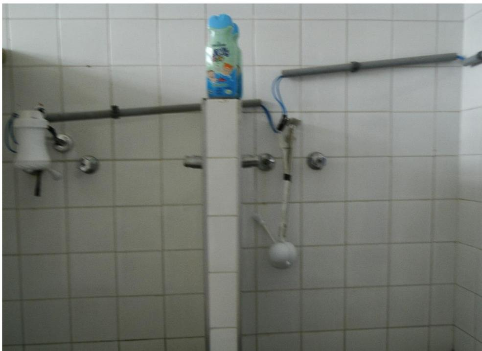
**Figura 71 – Instalação precária dos chuveiros elétricos**
