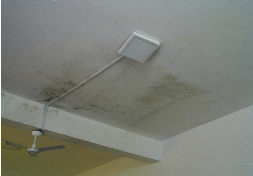
**Figura 56 – Sinais de mofo e infiltração no teto da Sala Pedagógica**
