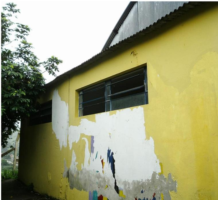
**Figura 19 – Pintura danificada e ausência de vidros**
