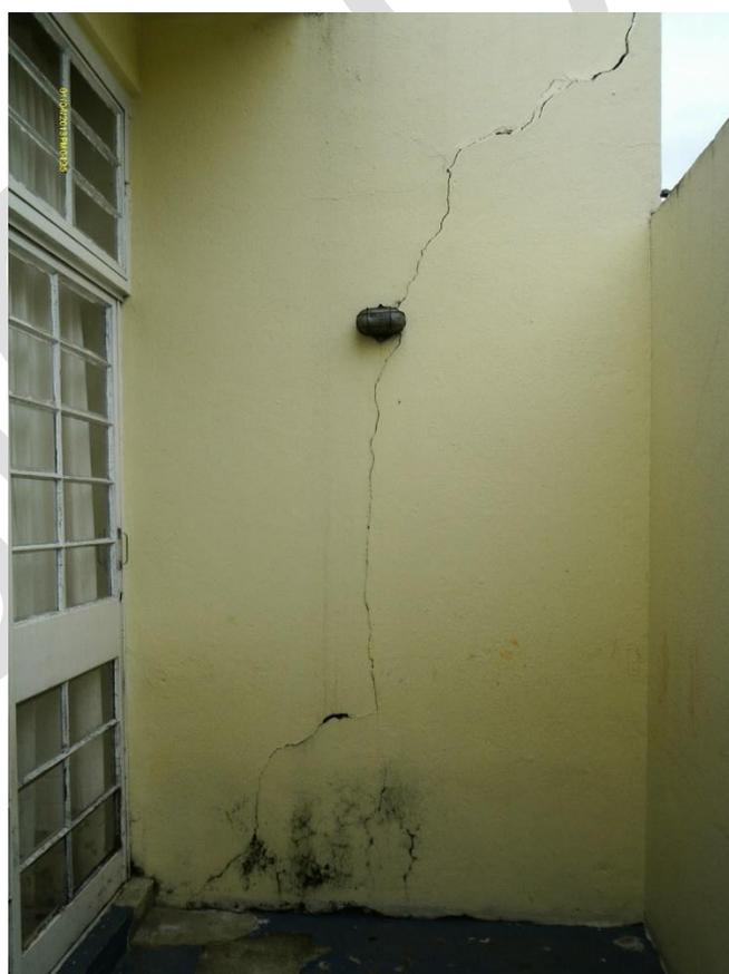
**Figura 64 – Muro rachado com sinais de mofo**
