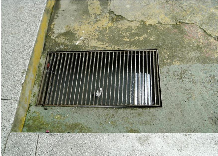
**Figura 26 – Grelha com problemas de escoamento de águas pluviais**
