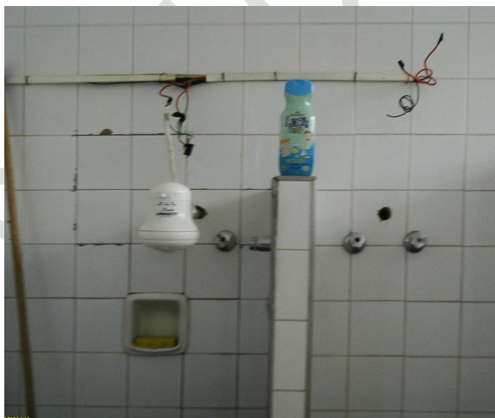
**Figura 72 – Instalação precária dos chuveiros elétricos**
