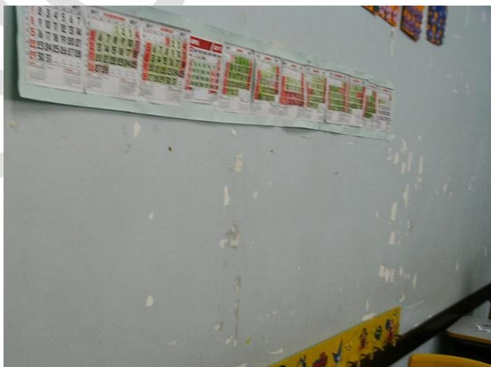
**Figura 51 – Pintura descascada em sala de aula**
