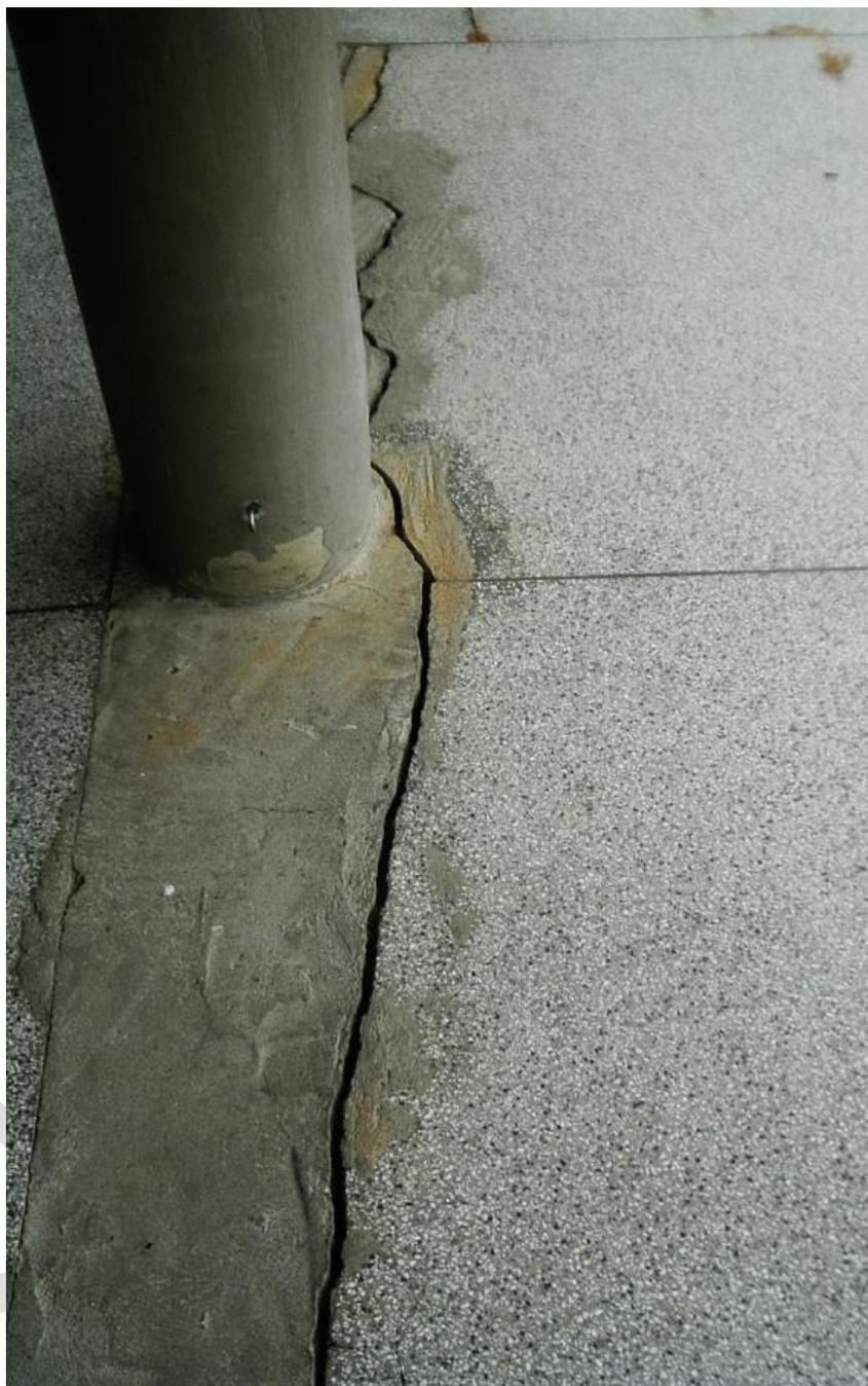
**Figura 11 – Detalhe de rachadura junto à pilastra**
