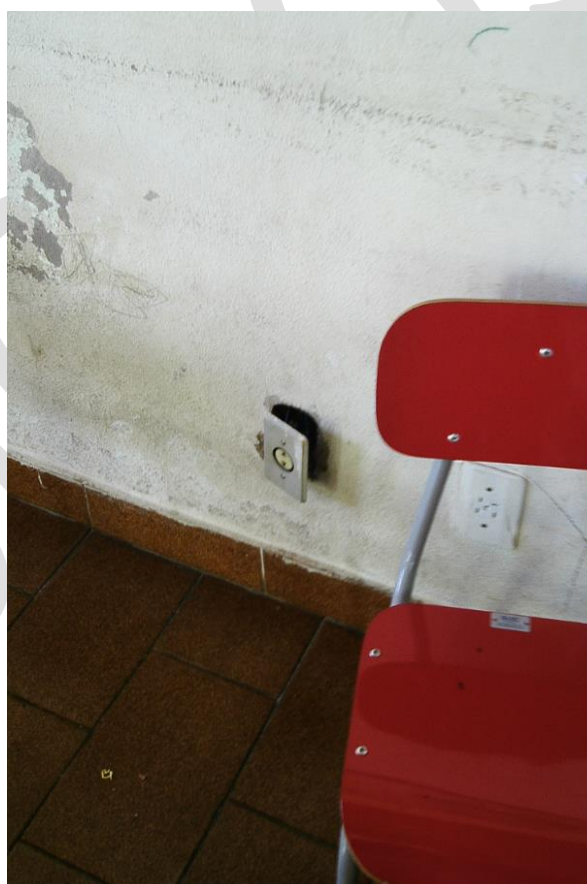
Figura 21 - Espelho de tomada solto
