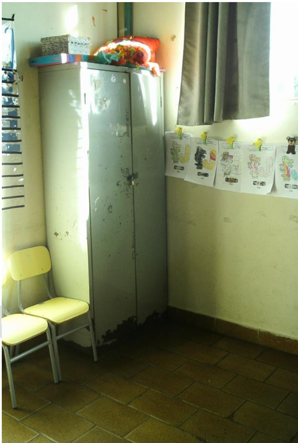
Figura 24 - Armário danificado em sala de aula
