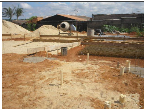
Vista na fundação
