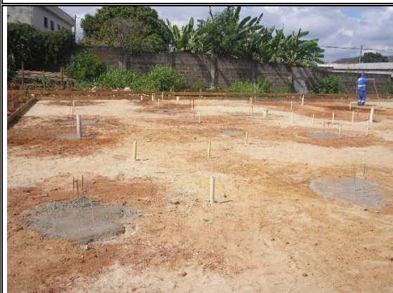
Vista da fundação
