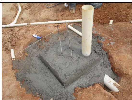
Vista bloco concretado
