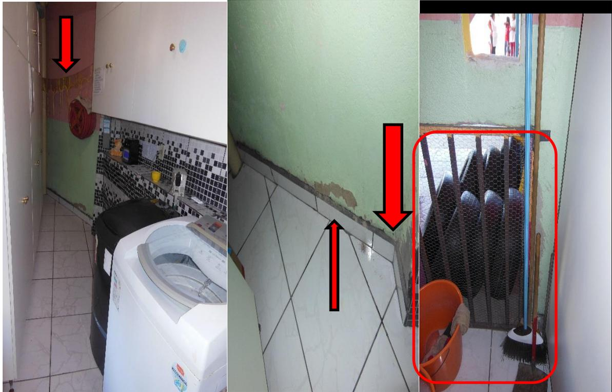
**Figura 39 - Creche Grupo de Amigos da Criança – Trabalho de campo realizado em 04/04 – Lavanderia em ambiente inadequado: espaço pequeno, estreito, sem iluminação natural e com pouca ventilação, localizada abaixo de uma escada onde a parede encontra-se com sinais de infiltração.**
