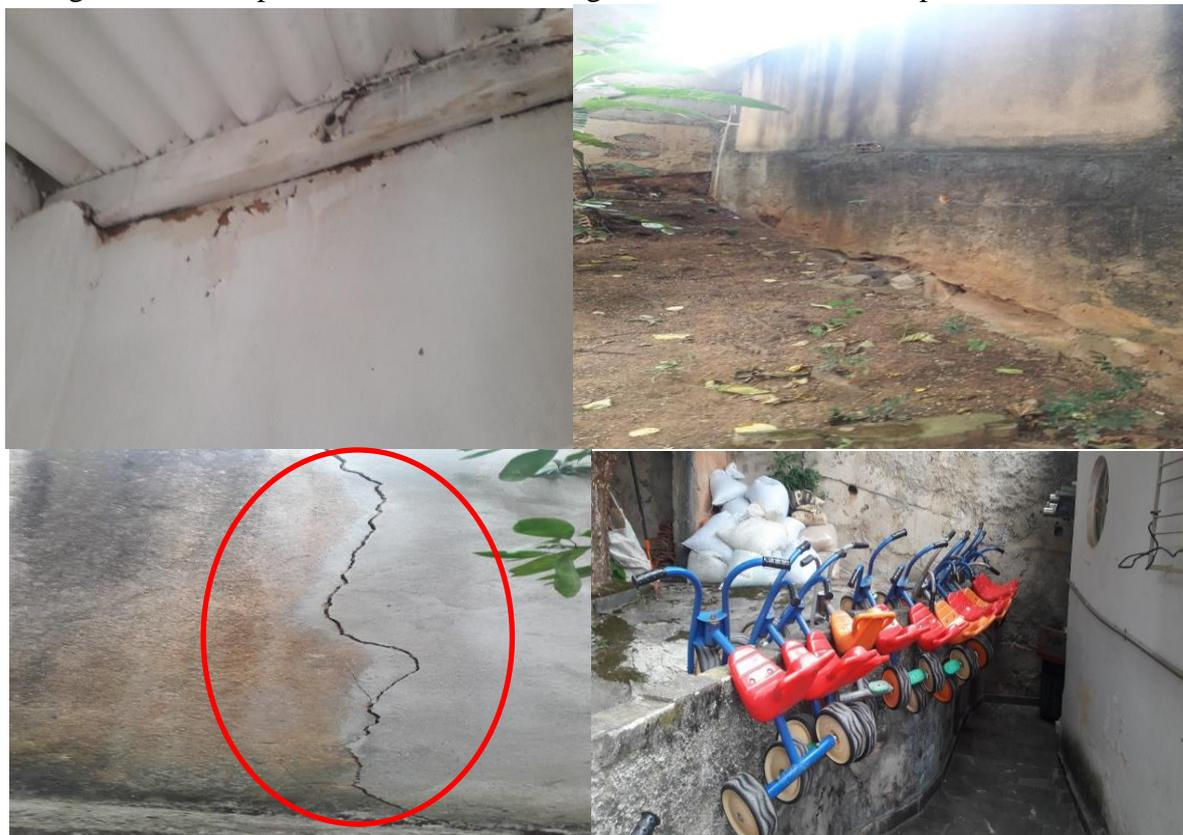
**Figura 13- Creche Nosso Abrigo Lactário – Trabalho de campo realizado em 19/04 – Conservação e limpeza precários, muro com rachaduras e buracos comprometendo a segurança das crianças, além de aparentes sinais de infiltração.**
