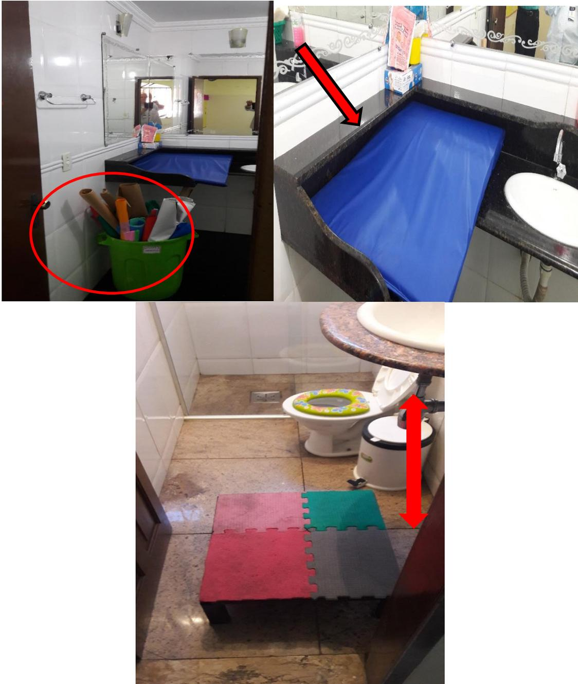
**Figura 37 - Creche do Conselho Comunitário Integração de Venda Nova - Trabalho de campo realizado em 20/04 – Banheiro infantil sendo utilizado como depósito de material, utilização de colchonete improvisado como local de troca de fraldas e lavatório inapropriado para a faixa etária, com altura desproporcional.**
