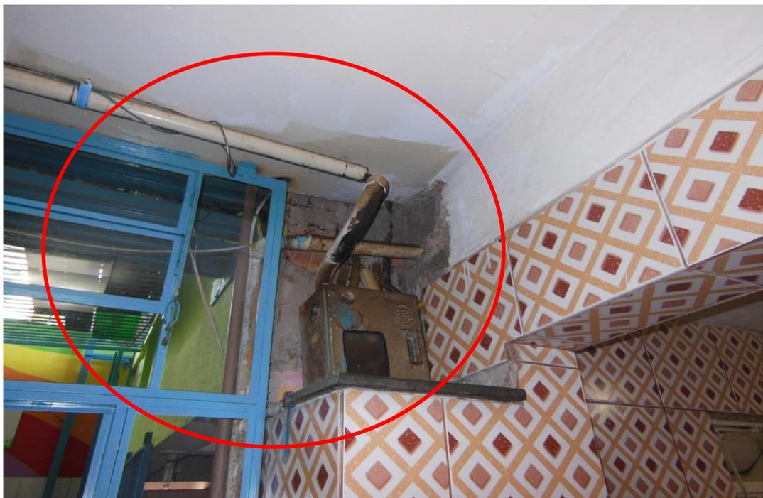
**Figura 30 - Creche Grupo de Amigos da Criança – Trabalho de campo realizado em 04/04 – Vão aberto, permitindo a entrada de chuva e fiação exposta comprometendo a segurança, além de instalações elétricas em péssimo estado e caixa/tubulação sucateada.**
