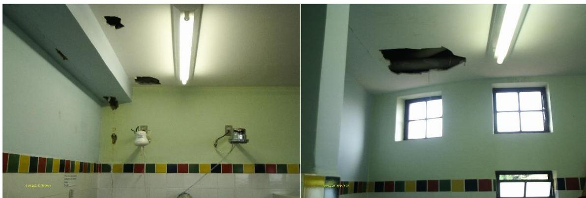
**Figura 8 - UMEI Taquaril – Trabalho de campo realizado em 5/04/2017 – Banheiro com teto danificado devido a provável vazamento e/ou infiltração.**
