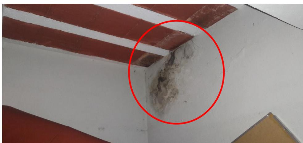
**Figura 29 - Creche Irmão Otho – Trabalho de campo realizado em 19/04 – Mobiliário em mau estado de conservação e com necessidade de reparos ou troca, tomadas sem proteção adequada, paredes com infiltrações e mofo e piso danificado e sem manutenção.**
