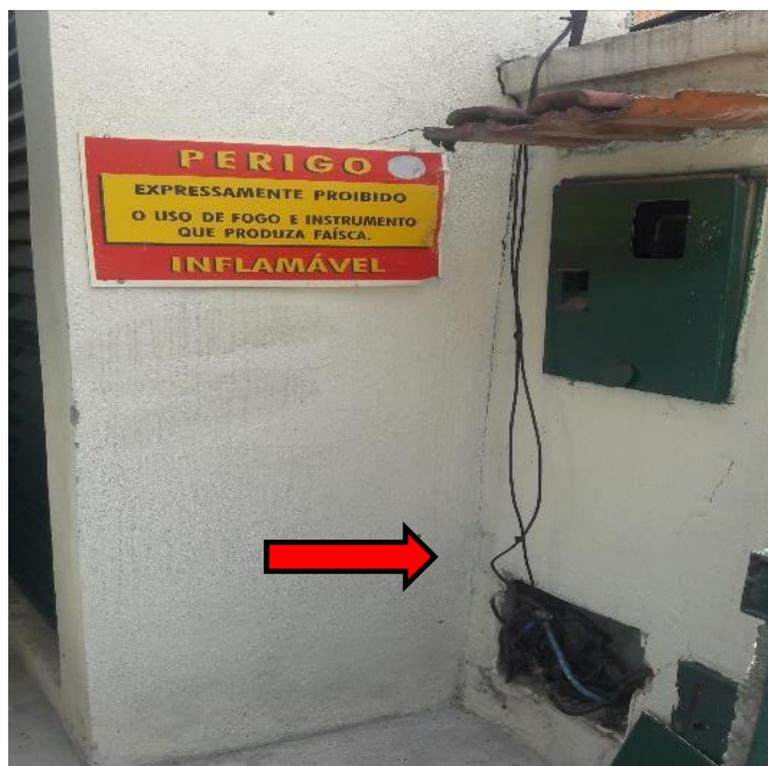
**Figura 48- Creche Irmão Otho – Trabalho de campo realizado em 19/04 – Central de gás sem ventilação nas laterais/alvenaria, instalada muito próxima à edificação e à caixa de passagem de fiação elétrica que se encontrava aberta e desprotegida.**
