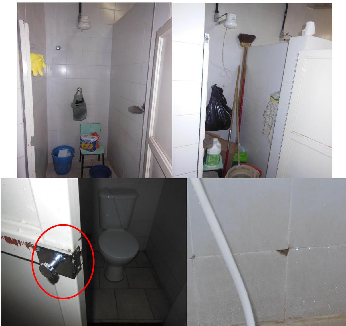
**Figura 36 - Creche Oficina Escola de Angelis – Trabalho de campo realizado em 10/04 – Banheiros infantis inutilizados. Área de chuveiro sendo utilizada como depósito de material de limpeza. Paredes com cerâmica danificada. Fechaduras das danificadas.**
