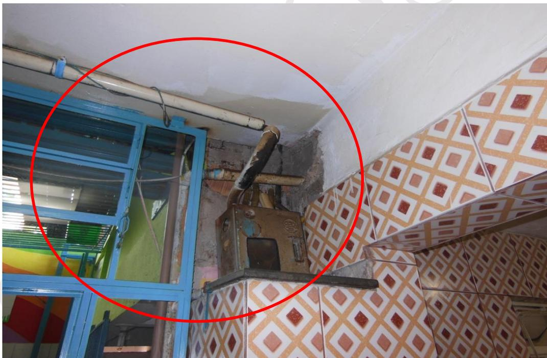
**Figura 30 - Creche Grupo de Amigos da Criança – Trabalho de campo realizado em 04/04 – Vão aberto, permitindo a entrada de chuva e fiação exposta comprometendo a segurança, além de instalações elétricas em péssimo estado e caixa/tubulação sucateada.**
