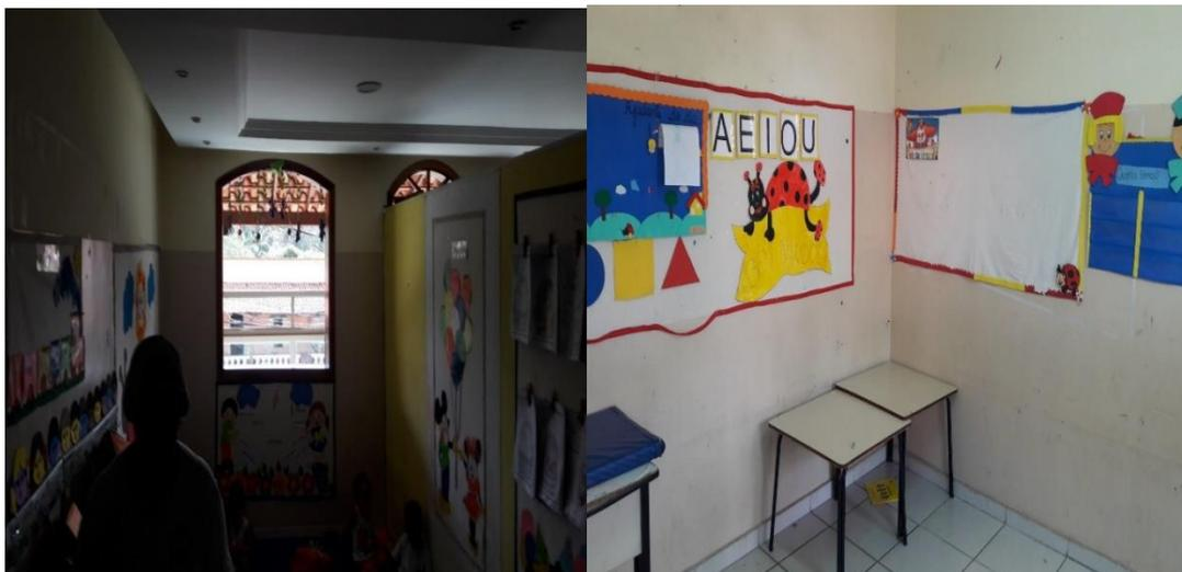
**Figura 53 - Creche do Conselho Comunitário Integração de Venda Nova–Trabalho de campo realizado em 20/04-Portas danificadas, mobília insuficiente, salas pequenas e com iluminação deficiente e divisória improvisada.**
