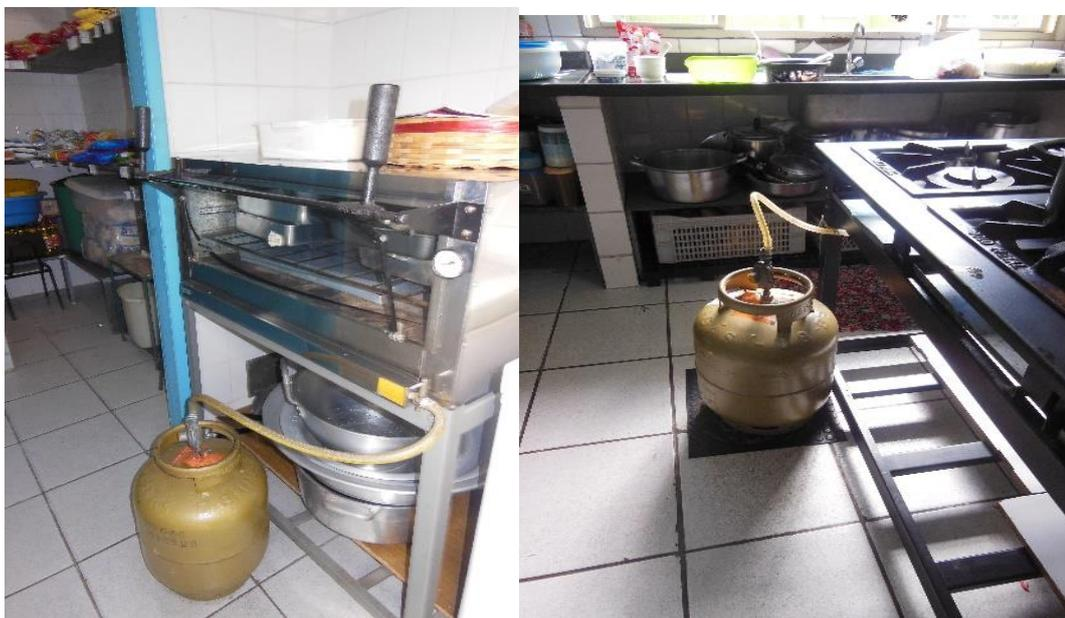
**Figura 102 - Creche: botijões de gás instalados e acondicionados de maneira inadequada.**
