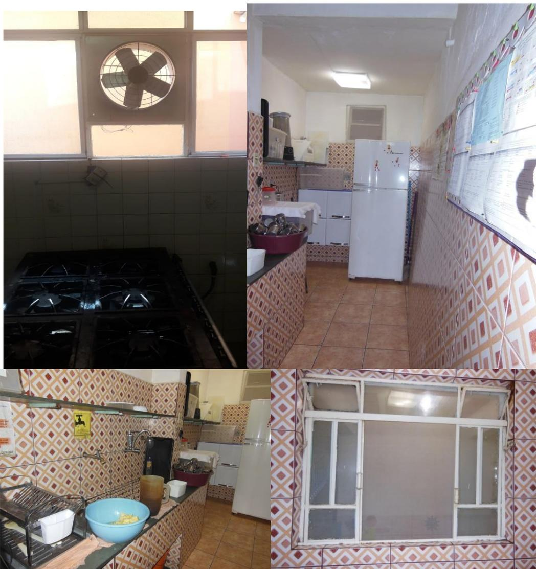
**Figura 99 - Creches: cozinhas em espaços reduzidos, mal dimensionados, sem sistema de exaustão, com ventilação e iluminação naturais precárias.**
