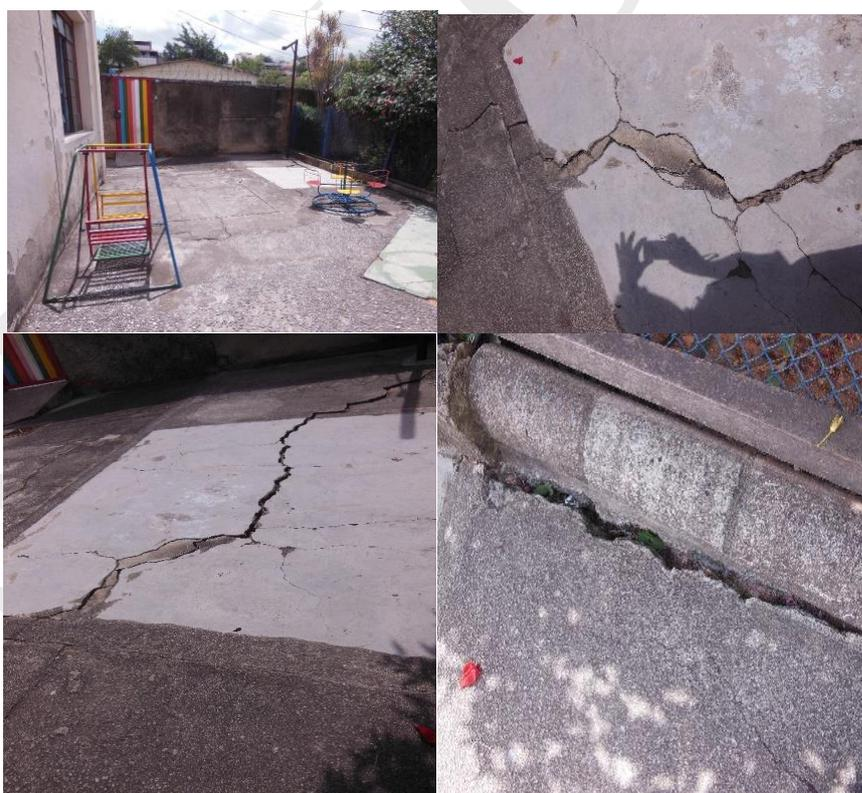
**Figura 67 - Creches conveniadas: visão geral das áreas externas, insuficiência de brinquedos e detalhes dos defeitos do piso.**
