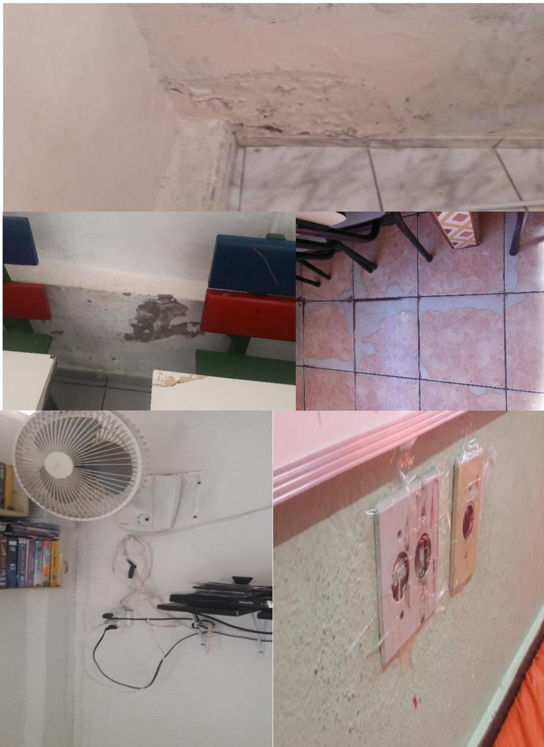
**Figura 86 - Creches: parede danificadas, sinais de infiltração, piso desgastado, fiação exposta, ausência de tomadas e manutenção deficiente**
