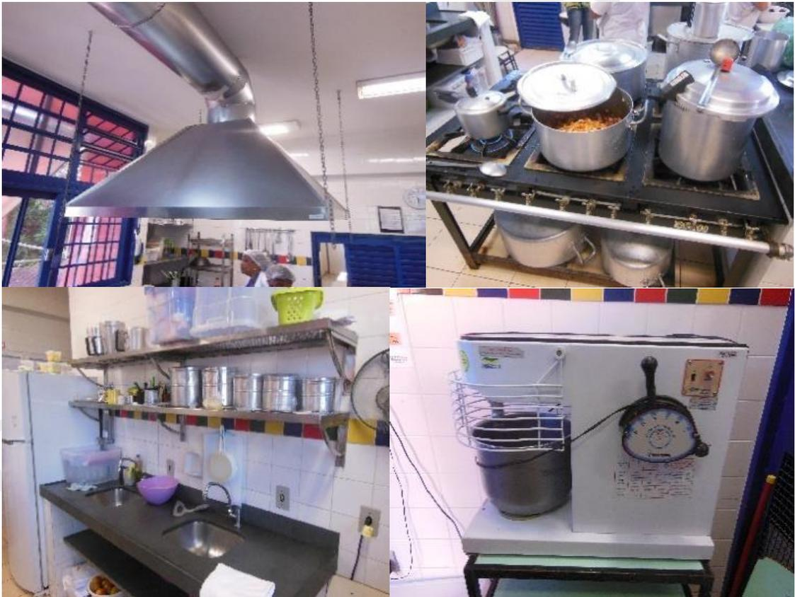
**Figura 78 UMEI-PPP – Cozinhas equipadas com coifa/exaustor, prateleiras em inox, utensílios novos e apropriados à cozinha profissional, equipamentos para uso industrial (fogão, forno, batedeira, liquidificador, etc.)**
