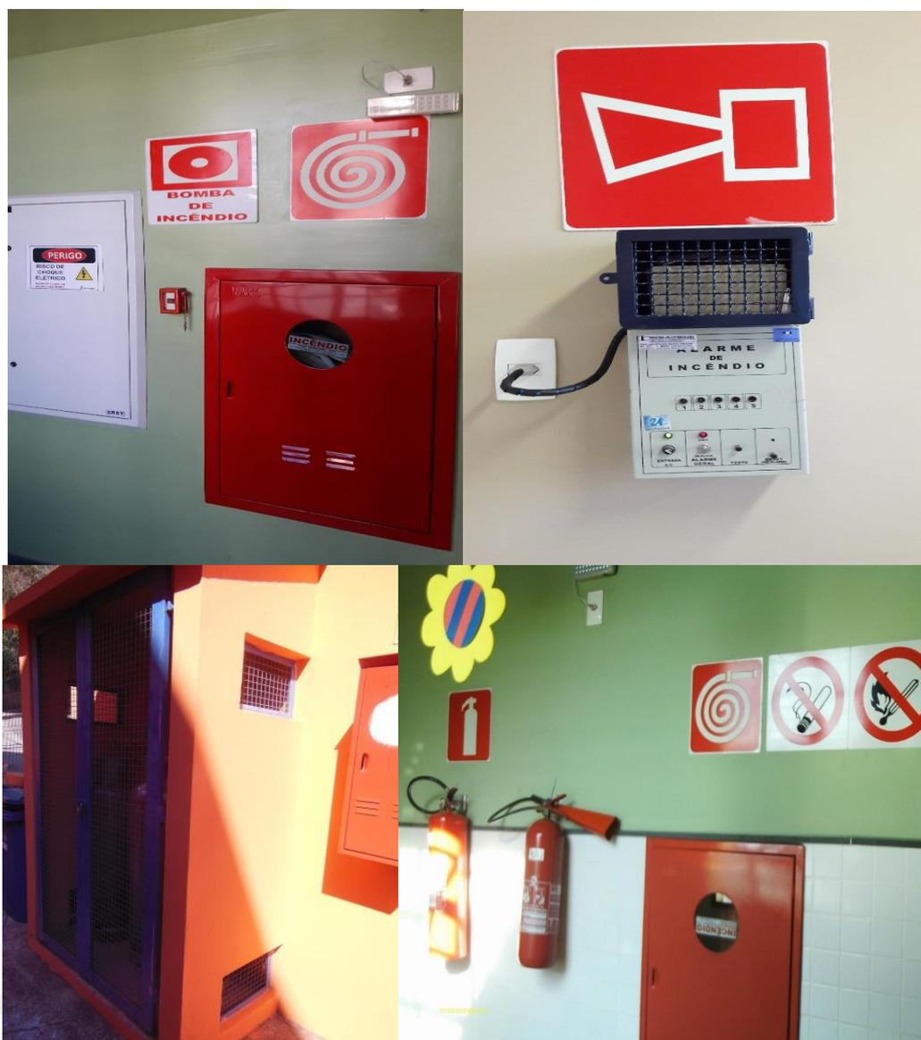
**Figura 101 UMEIs-PPP – Extintores em vários pontos da edificação, em áreas internas e externas, sinalização adequada, instalações de prevenção e combate a incêndio em conformidade com as exigências legais.**
